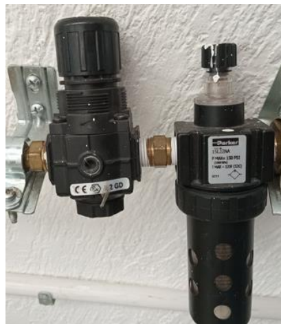
Figura 6.2.2 Unidad de mantenimiento del laboratorio de neumática.
