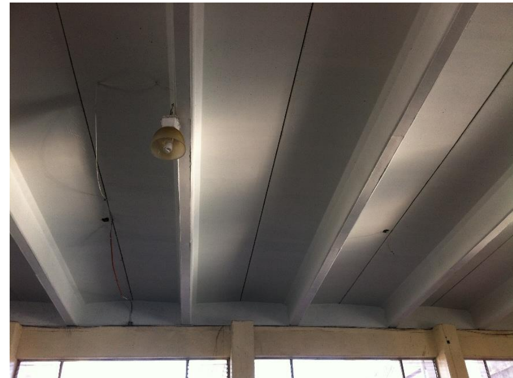
Imagen 12, Estructura de vigas tipo T, Ávila, Cortes, Cuautle, Rodríguez, Marzo 2014
