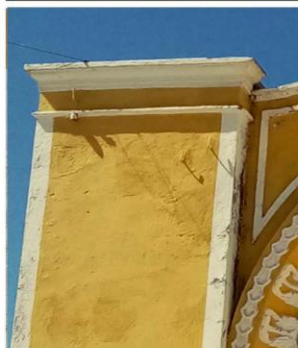
Imagen 4. Ganchos metálicos en fachada.
