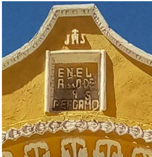
Imagen 32. Fecha de reforma en la fachada. Elaboración propia. (2022)
