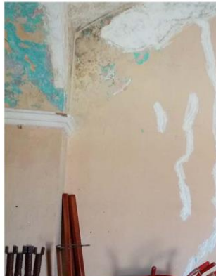
Imagen 4. Muro este de sacristía.
