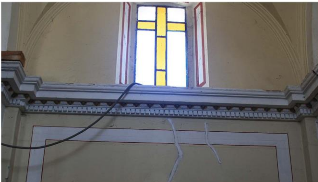
Imagen 3. Detalle de resane de fisuras en segundo tramo de la nave muro sur.
