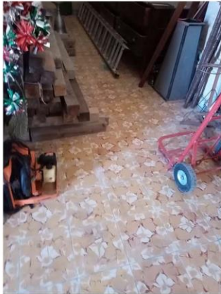
Imagen 1. Detalle de piso cen sacristía usada como bodega.
