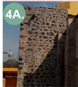
Fotografía muro primer tramo nave. Autor: Ma. Catalina Montiel Romero (2022)
