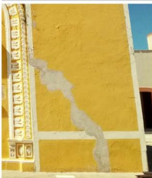
Imagen 3. Detalle de intervención con mortero cemento-arena.
