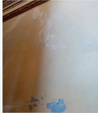
Imagen 2. Resane en muro norte de ábside.
