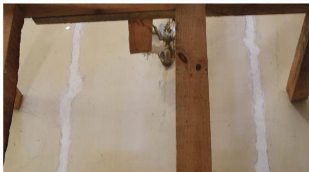
Imagen 4. Resane en muro de transepto norte.
