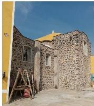
Imagen 6. Detalle de fachada lateral
