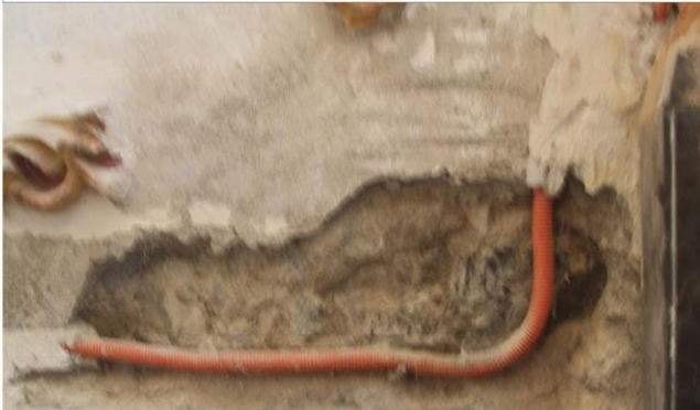
Imagen 2. Detalle de muro de transepto sur cara interna oeste en donde se aprecia la ranura en el muro para meter poliflex para instalación eléctrica.
