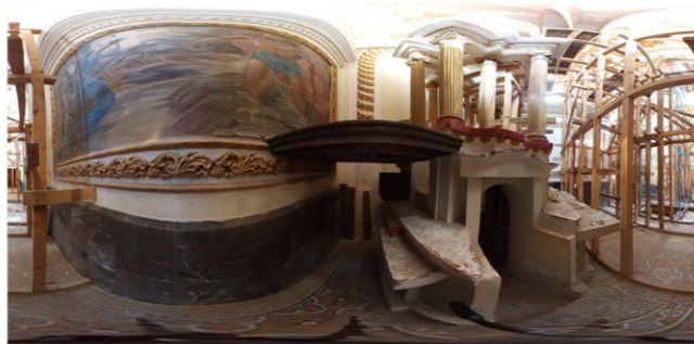
Imagen 5. Esférica de ábside que muestra los daños en el lienzo en muro así como suciedad en lambrín de mármol Santo Tomás.
