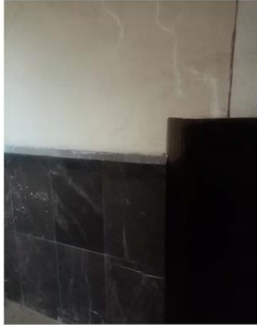
Imagen 1. Detalle de puerta a torre campanario
