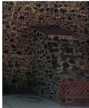
Imagen 2. Detalle de contrafuert en fachada posterior.
