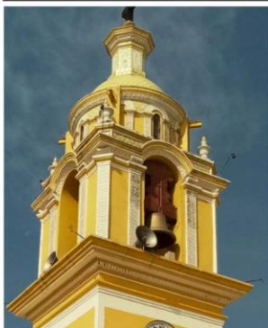
Imagen 5. Perfiles metálicos en cupulín de torre campanario.
