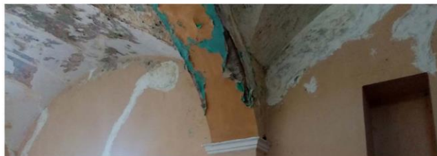
Imagen 5. Resane de mortero cal arena en muro de sacristía.
