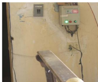
Imagen 4. Deterioro de pintura en muro norte.
