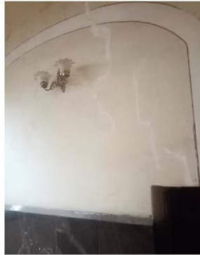
Imagen 2. Detalle de suciedad en pintura en muro norte
