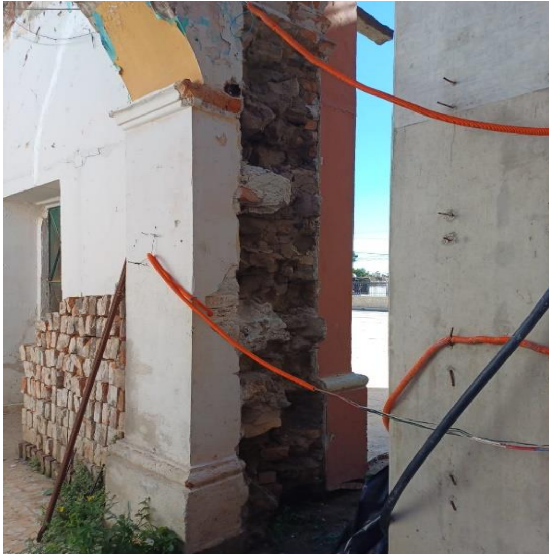
Imagen 76. Templo de San Cristóbal tras demolición Fuente: María Catalina Montiel Romero (2023)
