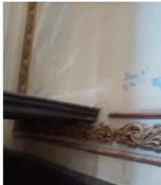
Imagen 3. Detalle de resane de muro.
