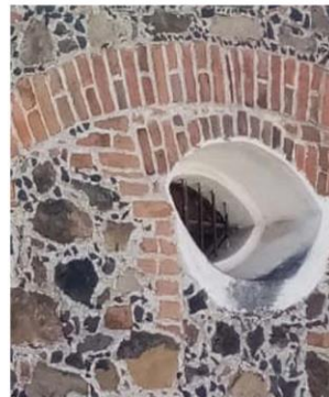
Imagen 4. Detale de estancamiento de agua en derrame de ventana.
