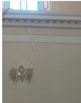
Imagen 4. Detalle de resane en muro norte.
