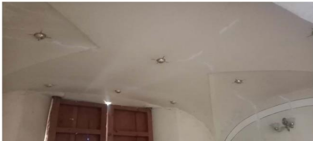
Imagen 2. Detalle de bóveda de lunetos en sección del sotocoro.
