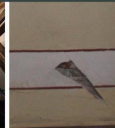
Imagen 2. Detalle de desprendimiento de aplanado.
