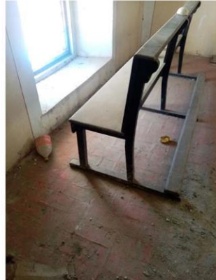
Imagen 4. Resane de fisura en muro este de coro.
