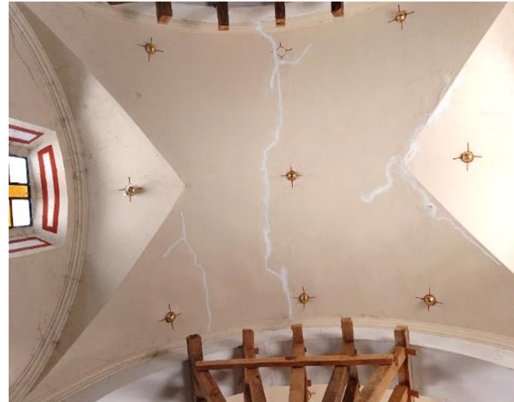
Imagen 63. Resane de grietas o fisuras en bóveda. Fuente: María Catalina Montiel Romero (2022)
