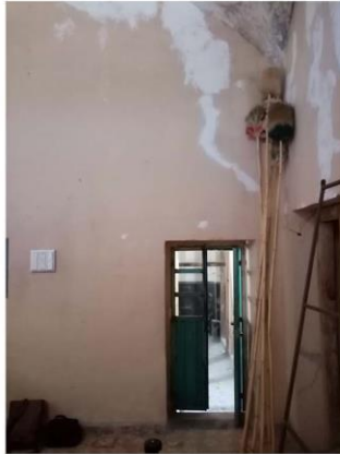
Imagen 1. Puesta de acceso de la sacristía a trancpto del templo.
