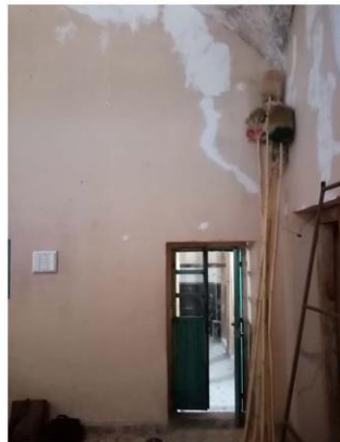
Imagen 4. Muro este de sacristía.
