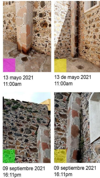
Imagen 60. Fachada muro este. Fuente: María Catalina Montiel Romero (2022)
