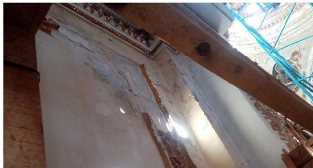
Imagen 5. Resanes en muro con mortero cal-arena.
