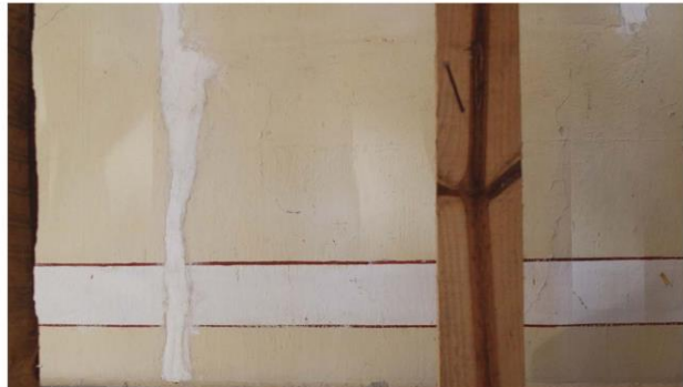
Imagen 3. Resane en muro de transepto norte con mortero cal-arena
