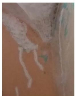
Imagen 4. Muro este de sacristía.
