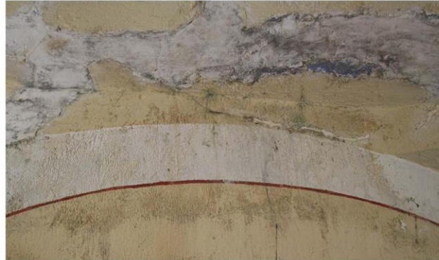
Imagen 1. Humedad por filtración en cúpula proveniente de acumulación de agua en azotea.
