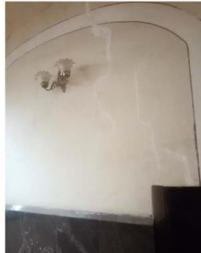
Imagen 2. Detalle de resane en muro norte.
