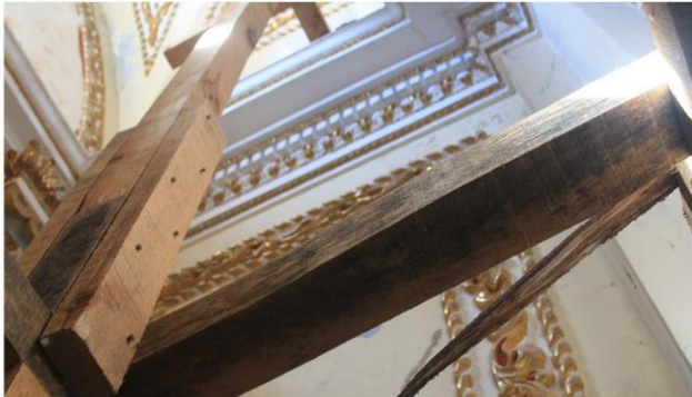
Imagen 2. Detalle de muro de trancpto sur cara interna oeste en donde se aprecia el da;o a la pintura y fisura en muro.
