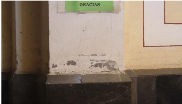
Imagen 3. Detalle de parte superior al labrín de mármol se aprecia como la humedad causó desprendimiento de pintura.
