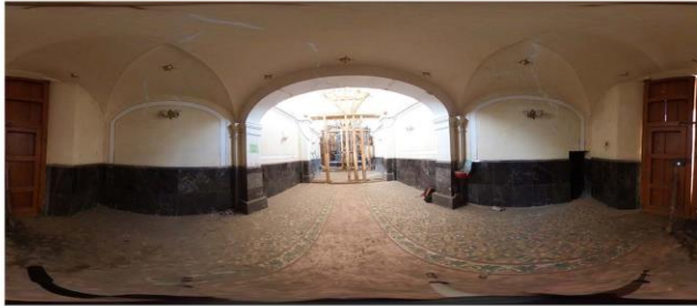
Imagen 1. Esférica de sotocoro en la que se aprecia el estado actual de la bóveda de lunetos.
