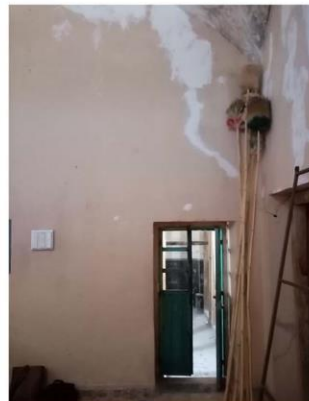
Imagen 4. Muro este de sacristía.
