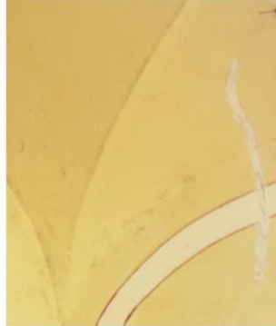
Imagen 2. Resane de fisura en muro de sotocoro.
