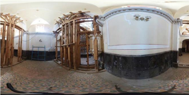
Imagen 5. Esférica de segundo tramo de nave.
