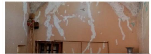
Imagen 5. Resanes en muro de sacristía.
