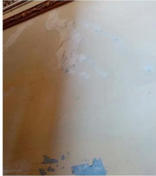
Imagen 1. Resane den muro norte de ábside.
