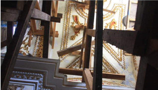
Imagen 1. Bóveda de lunetos con desprendimiento de pintura y de dorado a causa de la cimbra.
