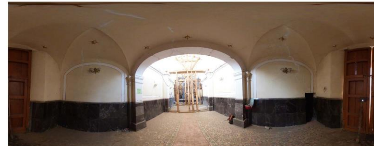
1. Fotografía esférica del sotocoro en la cual se observa puerta de acceso principal, la bóveda de lunetos y los muros que limitan el espacio, a la derecha se aprecia el acceso a la escalera de la torre campanario. Fotografía: Ana Vanesa Mejía. Noviembre 2022
