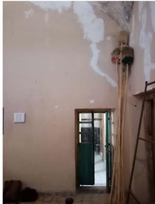
Imagen 1. Resane con mortero cal-arena en muro de sacristía.
