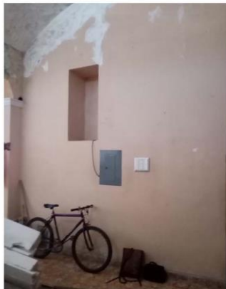
Imagen 3. Resane de mortero cal arena en muro de sacristía.
