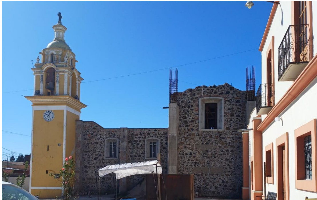
Imagen 77. Templo de San Cristóbal tras demolición Fuente: María Catalina Montiel Romero (2023)
