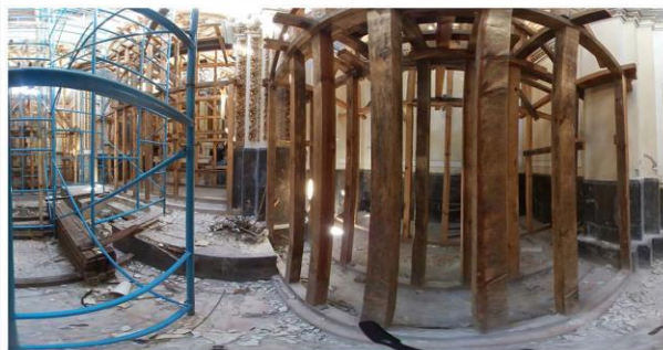
Imagen 3. Suciedad, mugre, basura y escombros en piso de transepto norte.
