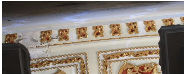
Imagen 3. Detalle de desprendimiento de pintura a causa de humedad por filtración en esquina de bóveda de crucería.
