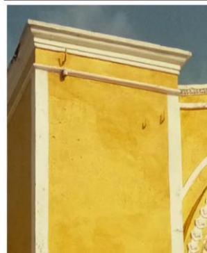
Imagen 6. Detalle de ganchos metálicos en fachada.
