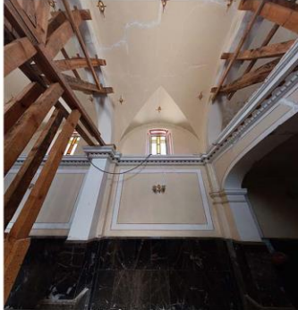
Imagen 1. Primer tramo de nave en muro norte.
