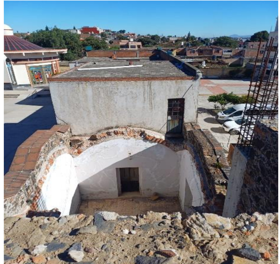
Imagen 75. Templo de San Cristóbal tras demolición Fuente: María Catalina Montiel Romero (2023)
