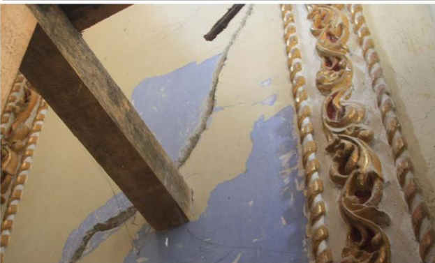
Imagen 4. Fisura y desprendimiento de pintura en cara interior oeste de trancpto sur.
