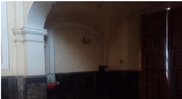
Imagen 3. Fotografía del muro norte del sotocoro de San Cristóbal Tepontla.
