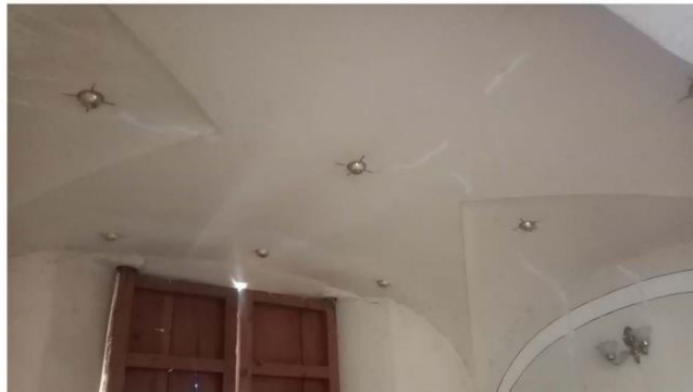
Imagen 2. Detalle de bóveda de lunetos en sección del sotocoro.
