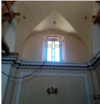
Imagen 3. Fotografía de segundo tramo de nave en muro norte.
