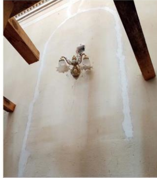
Imagen 1. Detalle de resane en muro de transepto.
