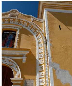
Imagen 2. Detalle de intervención de grieta.
