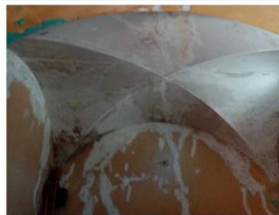
Imagen 4. Bóveda de crucería en sacristía.
