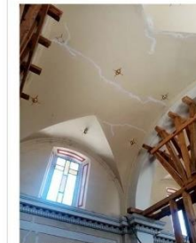
Imagen 2. Segundo tramo de la nave con resanes.
