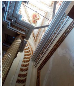
Imagen 4. Resane de muro.
