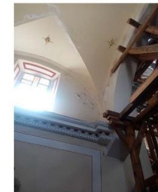
Imagen 3. Segundo tramo de la nave con resanes.
