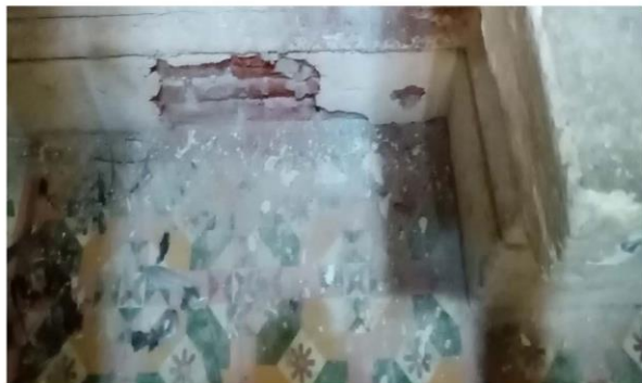
Imagen 2. Detalle de piso de transepto sur cubierto en material que se desprende de la pared y suciedad general.
