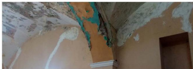
Imagen 5. Resane de mortero cal arena en muro de sacristía.
