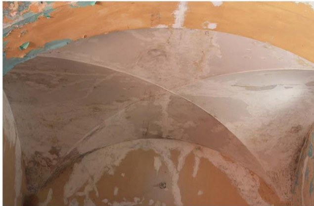
Imagen 1. Detalle de bóveda de crucería en sacristía en donde se aprecia policromía y falta de pintura.
