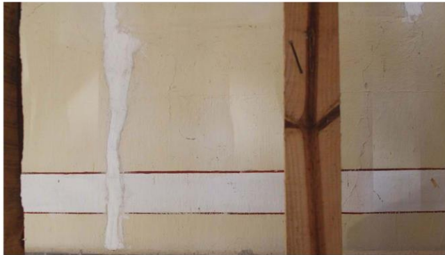
Imagen 3. Detalle de deterioro de pintura en el que se observan rayones, manchas de mezcla y suciedad general.
