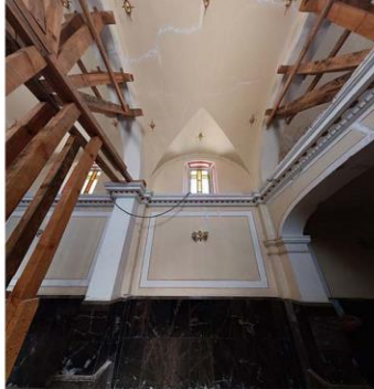
Imagen 1. Primer tramo de nave en muro norte.
