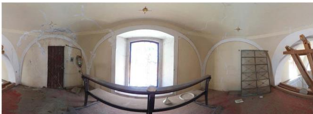
Imagen 5. Resane de fisura con mortero cal arena.
