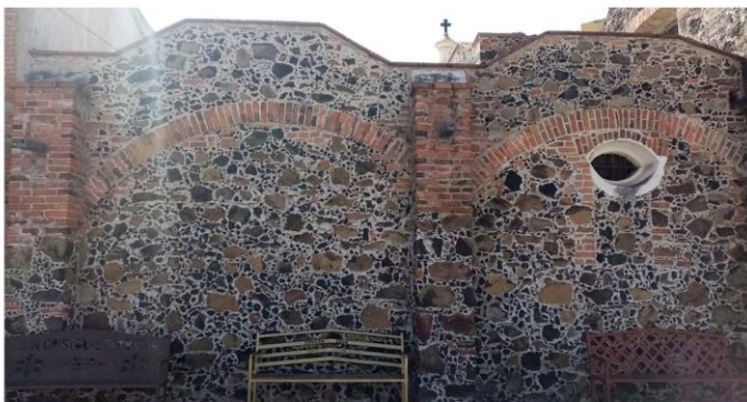
Imagen 5. Fachada posterior de sacristia.
