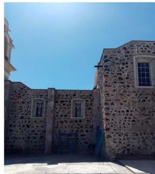
Imagen 4. Intervención con concreto en muro de transepto.
