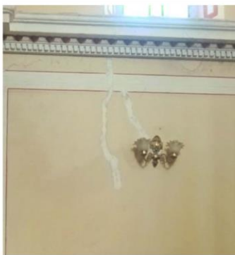
Imagen 3. Fotografía de segundo tramo de nave en muro norte.
