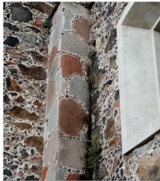
Imagen 4. Detalle de helechos en unión entre pilastra y muro.
