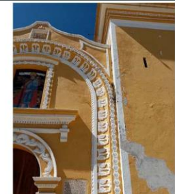
Imagen 2. Detalle de vegetación en la junta constructiva.
