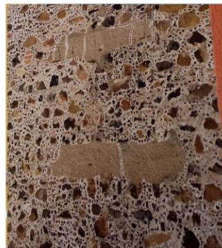
Imagen 6. Intervención con concreto en muro de transepto norte.
