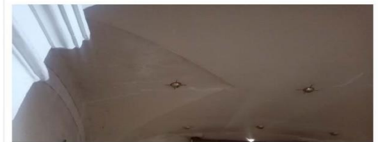
Imagen 3. Detalle de resanes en sección de bóveda de sotocoro.
