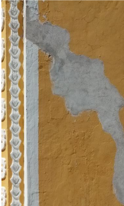
Imagen 62. Fachada muro sur, detalle de resane en torre campanario. Fuente: María Catalina Montiel Romero (2022)
