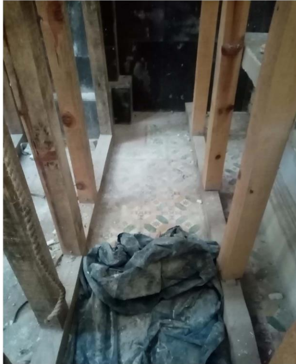
Imagen 1. Piso de transepto sur en donde se apoyan polines, cubierto con bolsas de basura negras para su protección.
