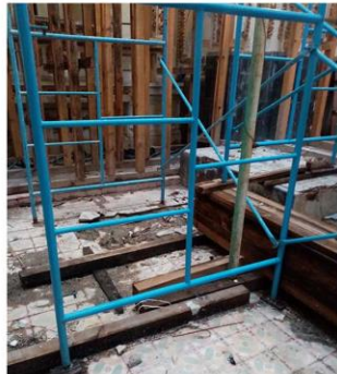
Imagen 3. Detalle de polines y andamios en piso roto.
