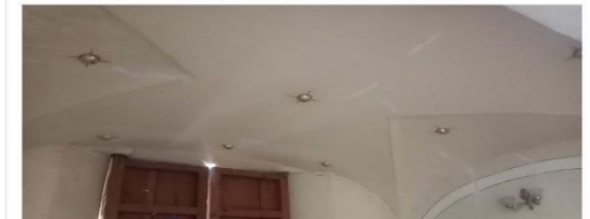
Imagen 2. Detalle de bóveda de lunetos en sección del sotocoro.
