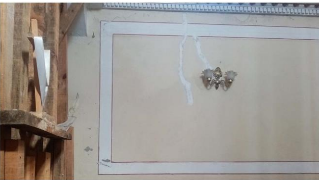
Imagen 5. Detalle de resane en segundo tramo de la nave muro norte.
