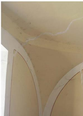
Imagen 3. Resane de fisura en muro este de coro.
