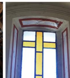
Imagen 4. Detalle de humedad en derrame de ventana.
