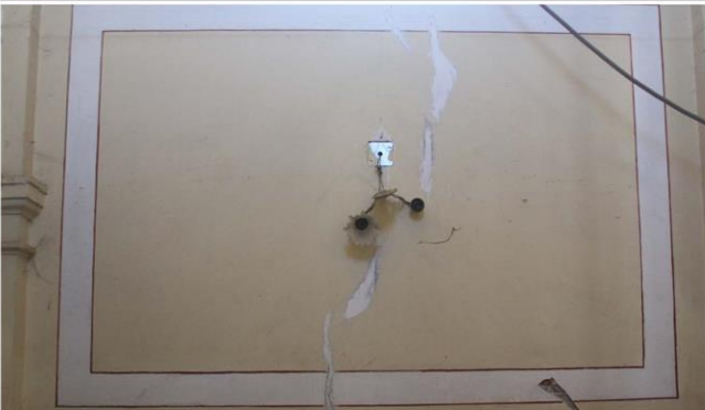
Imagen 4. Detalle de resane en primer tramo de la nave en el muro sur.
