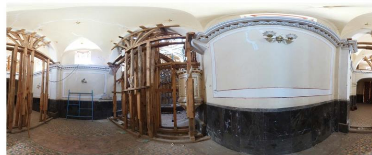
3. Fotografía esférica del segundo de la nave que antecede al crucero, está delimitado por muros con lambrín y cubierto por bóveda de crucería. Fotografía: Ana Vanesa Mejía. Noviembre 2022
