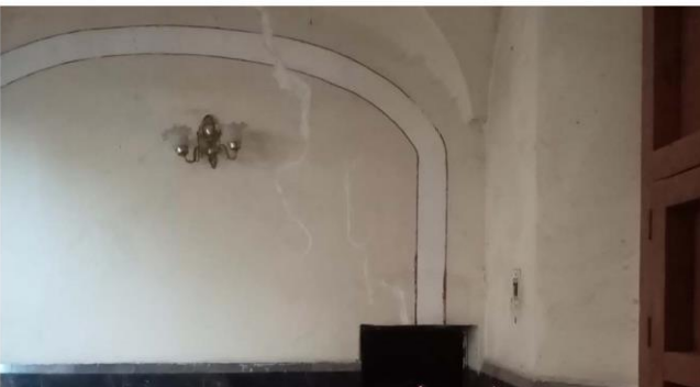
Imagen 3. Detalle de resane con mortero cal arena en muro norte del sotocoro.
