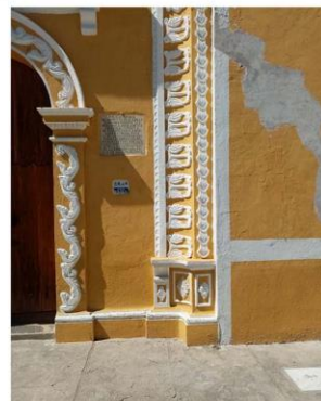
Imagen 5. Detalle de desprendimiento de pintura en torre campanario.
