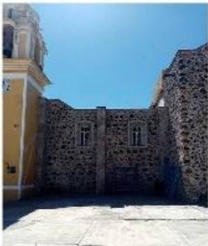
Imagen 5. Fachada lateral con andamios.
