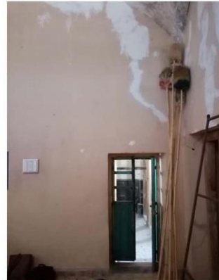
Imagen 4. Muro este de sacristía.
