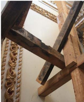
Imagen 3. Polín de madera recargado en muro este de transepto sur.
