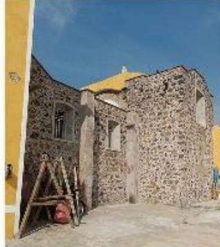
Imagen 2. Detalle de fachada lateral
