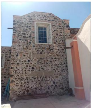
Imagen 5. Intervención con concreto en muro de transepto norte.
