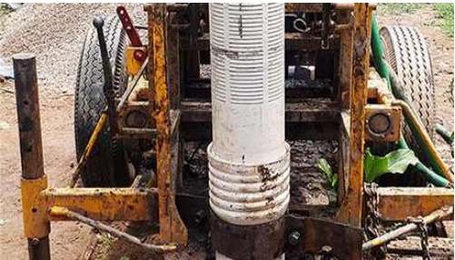
Tubo de PVC ranurado para pozo ademe. Datos de Ficha técnica del proveedor. Recuperada de: https://www.tubosparadrenaje.com/tuberia-de-pvc/para-ademe-de-pozo-profundo/
