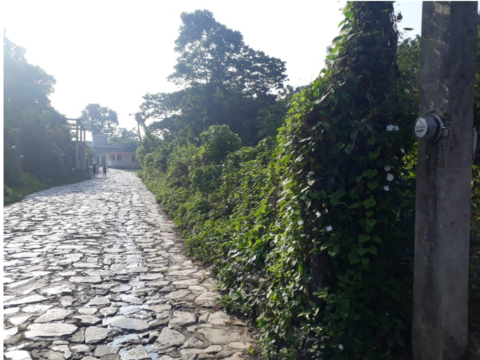
Imagen 4. Lado Norte. Vialidad principal del terreno. Fotografía tomada por el autor.
