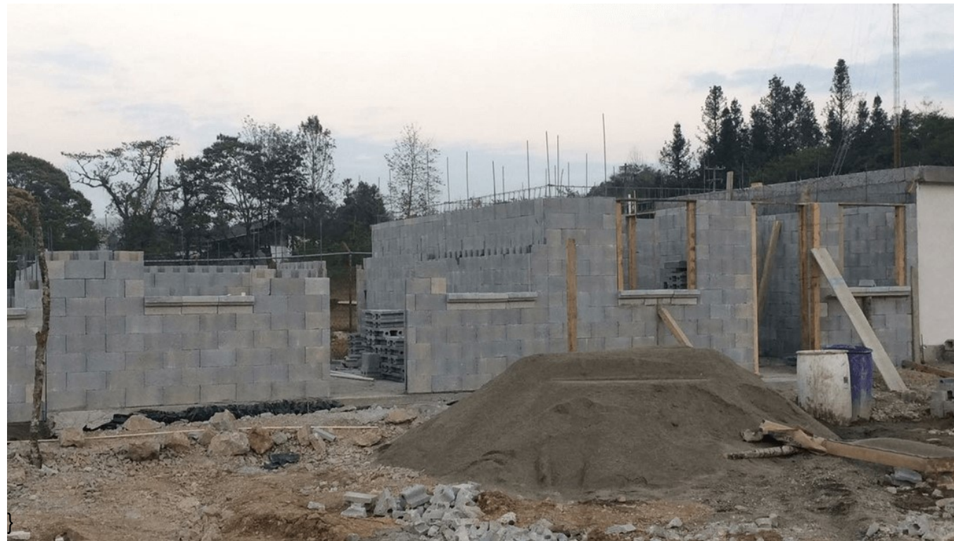
Imagen 17. Las casas modernas de Zacatipan. Construcción de Block.
