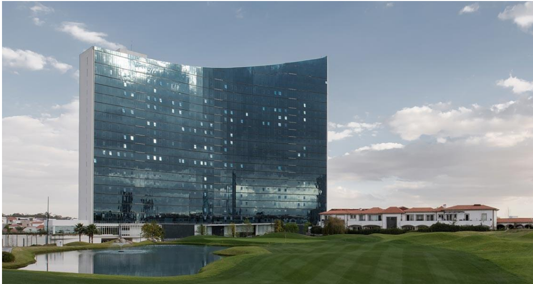
Figura 18. La Vista Country Club. Vista frontal del edificio departamental recubierto de cristales que reflejan el exterior, en la que también se puede observar la arquitectura tipo californiano de las casas, un lago artificial y el césped finamente podado que recubre todo el campo de golf. 69
