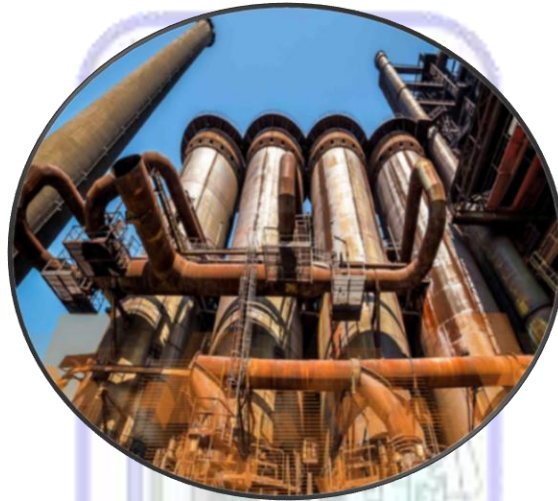
Figura 1. Corrosión de metales en la industria.
