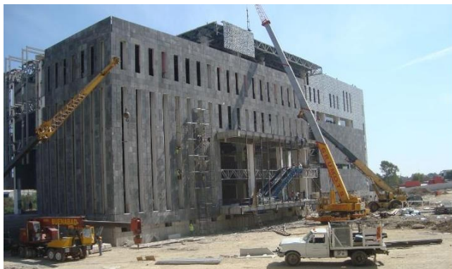
IMAGEN 24 PANELES PREFABRICADOS CIS RECUPERADO DE http://www.skyscrapercity.com/showthread.php?t=1376775&page=1
