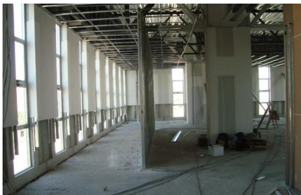
IMAGEN 26 MUROS INTERNOS LIJEROS CIS RECUPERADO DE http://www.skyscrapercity.com/showthread.php?t=1376775&page=14
