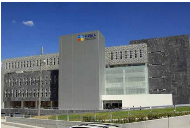
IMAGEN 14 EDIFICIO TORRE EJECUTIVA CIS RECUPERADO DE http://consulinte.com/portafoliodeproyectos/cis-estadio-teleferico/
