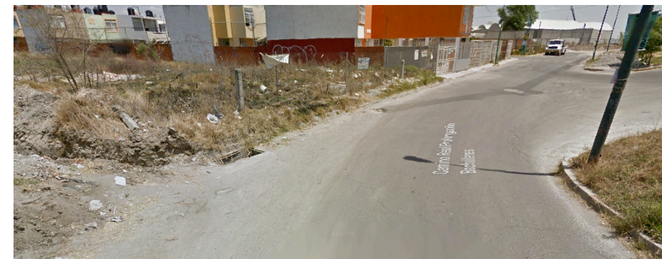
Fotos 49-53: Condiciones de las calles frontales al terreno, banquetas y guarniciones.
