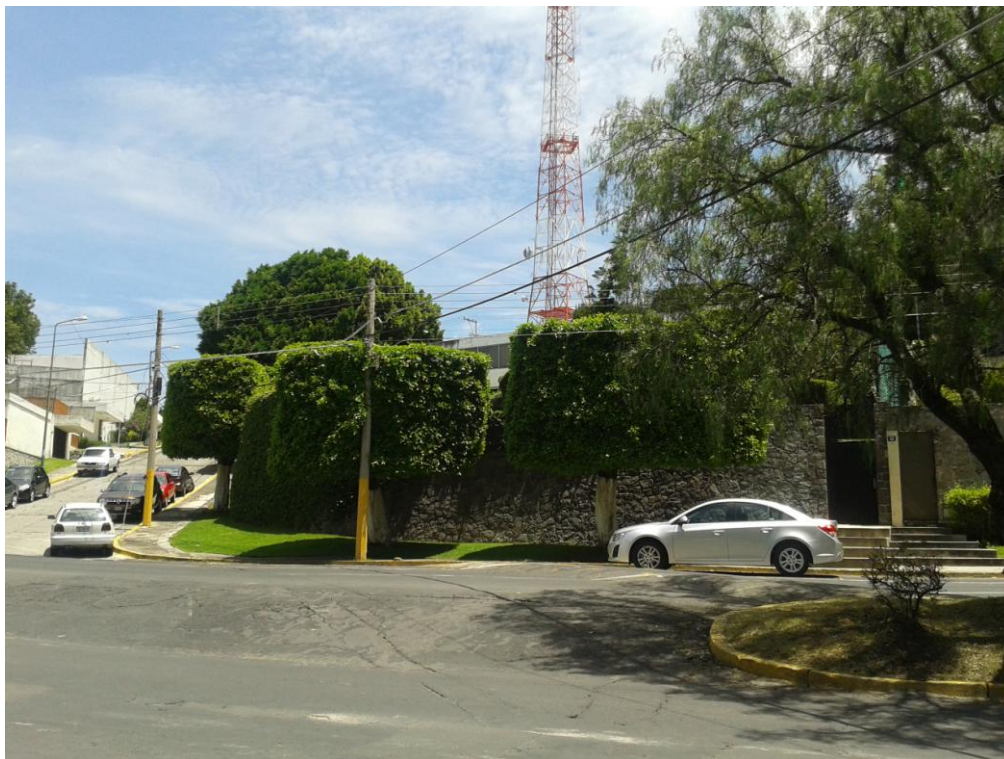
Foto 70. Vista de fachada de casa 2 desde Teziutlán Sur
