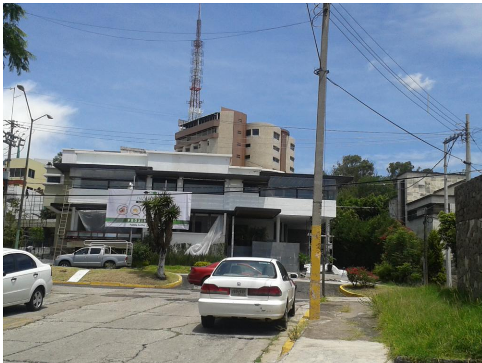
Foto 67. Casa aleña a casa 1 remodelada para uso restaurantero.
