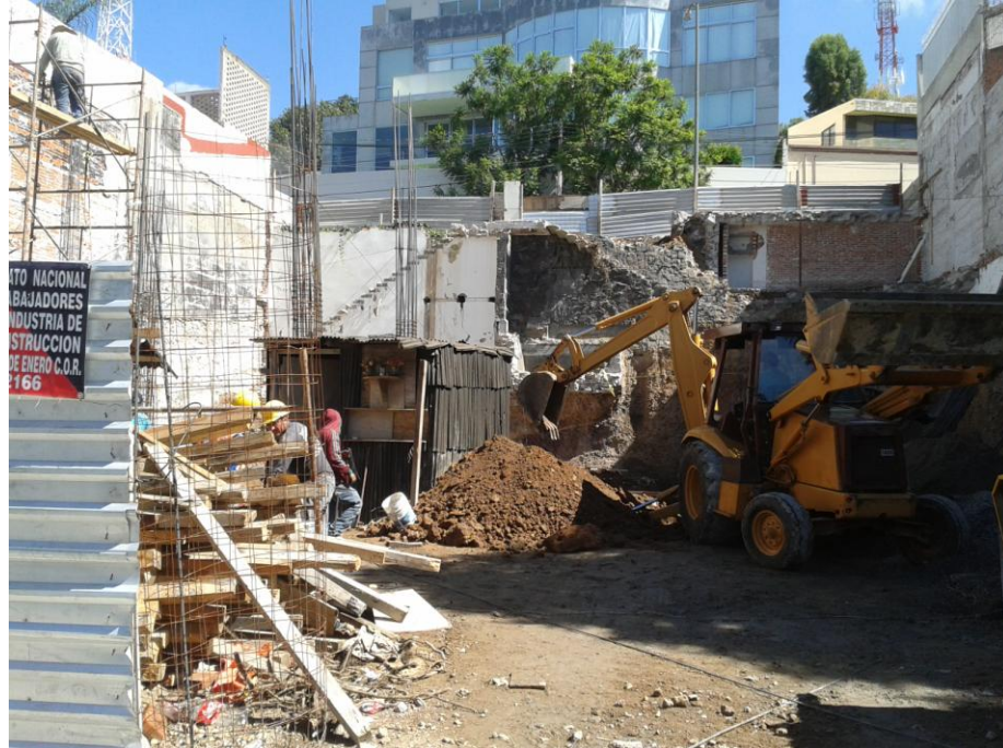
Foto 48. Demolición de una de las Casonas de La Paz
