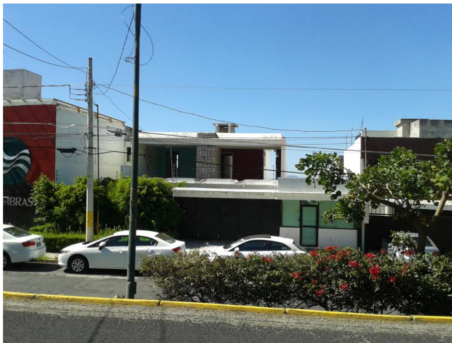
Foto 53. Otro ejemplo de demolición de un inmueble.
