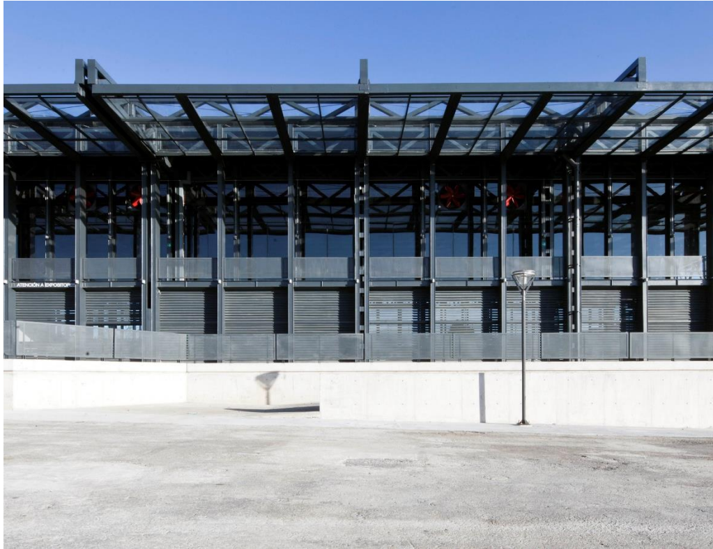
Imagen 22: Vista Recinto Ferial C.U. Sobre una Plataforma de Concreto.
