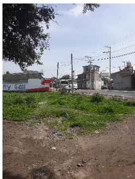
Imagen 138: Fotografía de poste de cfe y luminarias.
