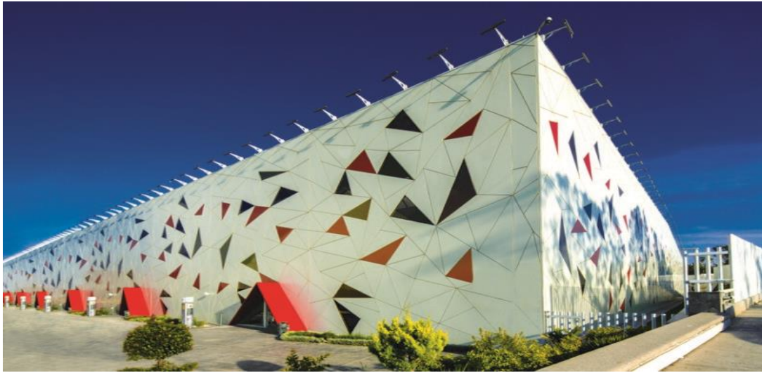
Imagen 9: Vista Fachada Principal del Recinto
