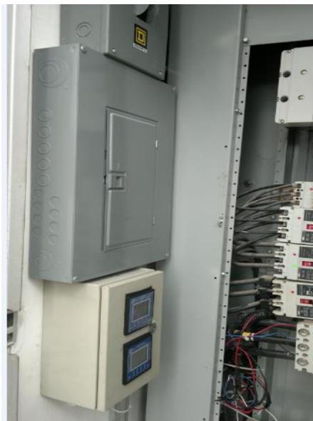
Fig. 4.9 Equipos de medición junto a tablero principal de distribución
