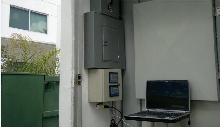
Fig. 4.10 Medidores Elnet conectados y comunicados con equipo de cómputo
