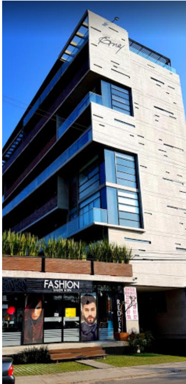
Imagen.10.5 Edificio ENE. Google maps
