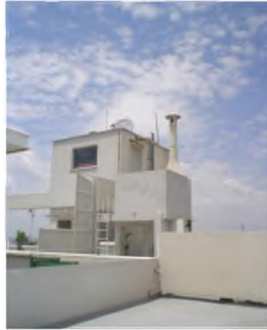
FOTO: CUARTO DE MÁQUINAS DE ELEVADOR
