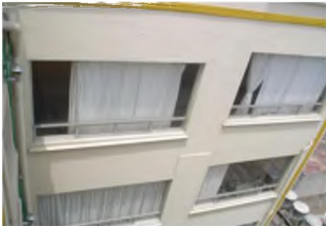
FOTO: RED DE INSTAL. DE GAS, HIDRÁULICA Y SANITARIA.
