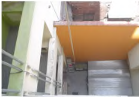
FOTO: RED INSTALACION ELÉCTRICA
