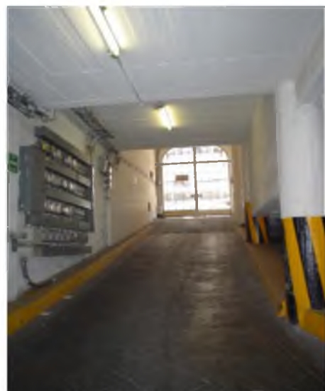
FOTO: RAMPA ACCESO Y SALIDA DE AUTOS
