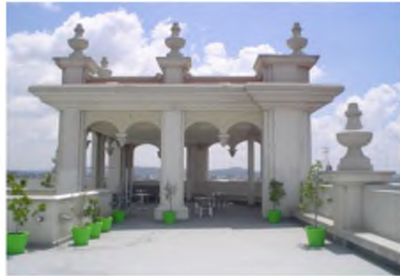
FOTO: VISTA DE TERRAZA
