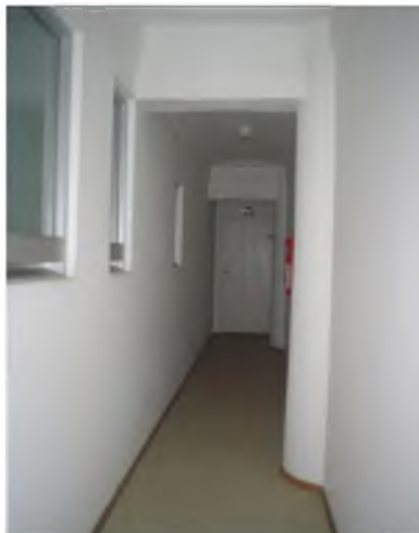
FOTO: PASILLO DE ACCESO A DEPTOS.
