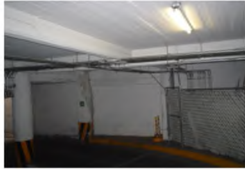
FOTO: RAMPA ACCESO Y SALIDA DE AUTOS
