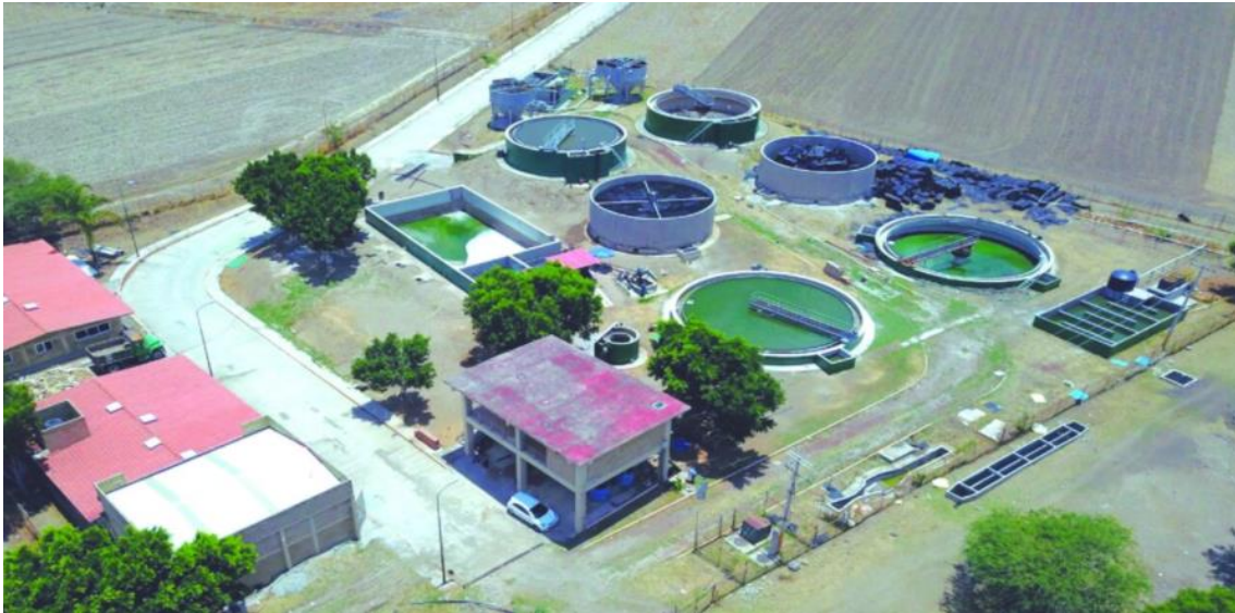
Fotografía 1. Distribución de los procesos de la PTAR de Izúcar de Matamoros (Onofre, 2020)
