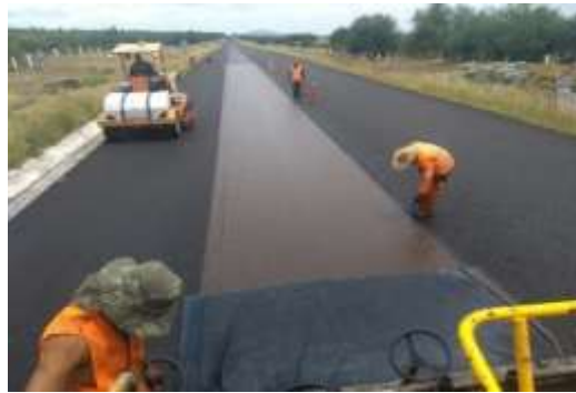
Figura 3.- Colocación de Slurry Seal (Fuente)
