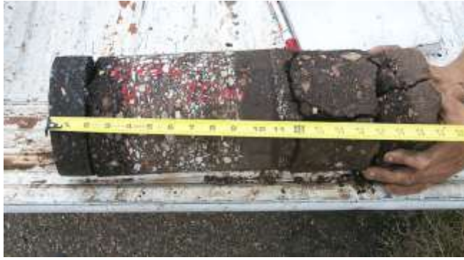
Figura 41.- Capas asfálticas de un pavimento (extracción de núcleo).
