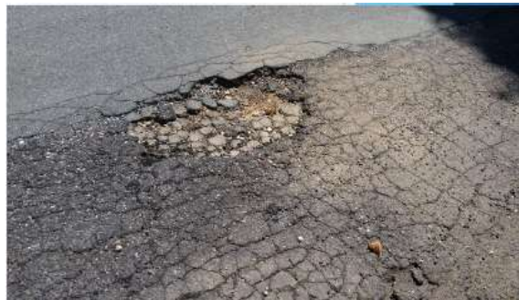
Figura 5.- Formación de bache en la superficie (BUAP, 2018)
