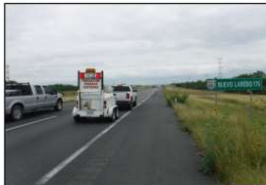
Figura 22.- Medición de deflexiones en carreteras
