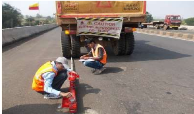
Figura 8.- Ensayo de deflexión utilizando la viga Benkelman (BUAP, 2018)
