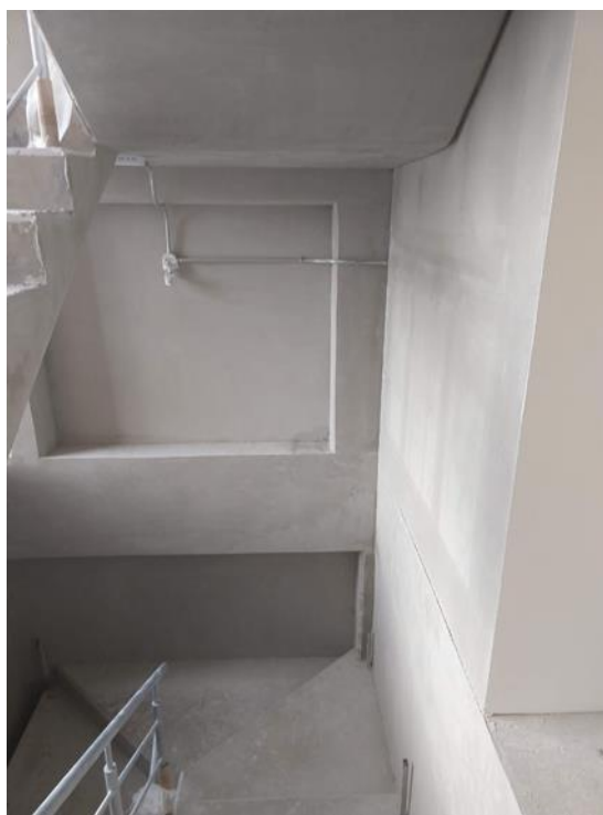
Figura 26. Aplicación de OVP blanco. Edificio Artema. Puebla, México (2018). Elaboración propia.
