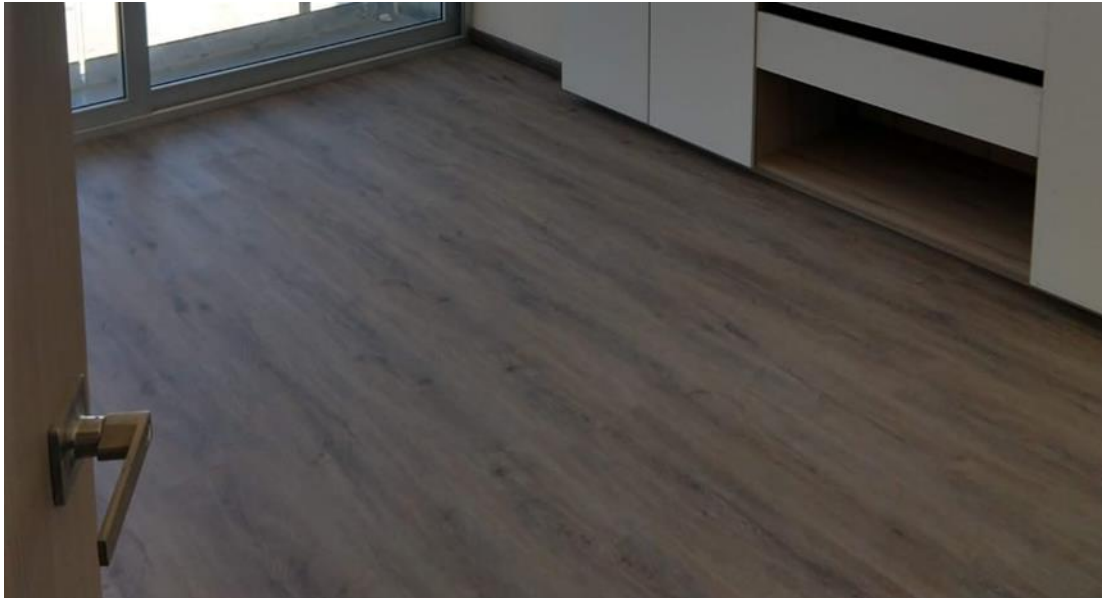
Figura 34. Piso Sentai Flotado. Edificio Artema. Puebla, México (2018). Elaboración propia.
