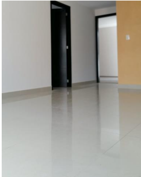
Figura 32. Piso de porcelanato. Torre Belisario. Puebla, México (2016). Elaboración propia.
