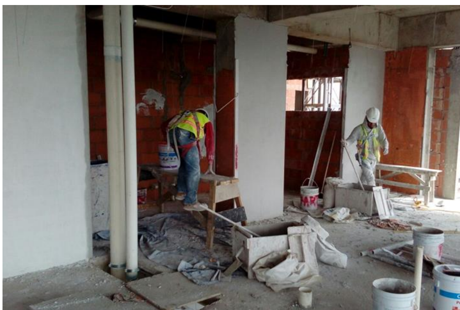
Figura 5. Aplicación de yeso. Edificio Artema, Puebla, México (2018) Elaboración propia.
