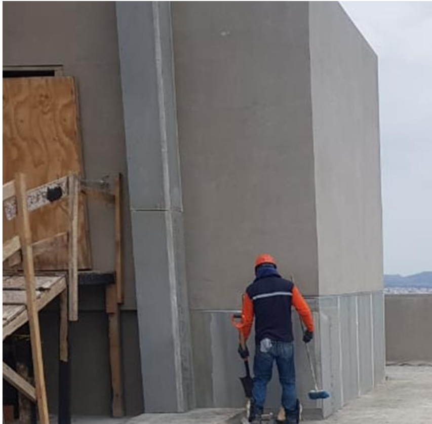
Figura 14. Instalación de Panel de Cemento. Edificio Artema. Puebla, México (2018). Elaboración propia.
