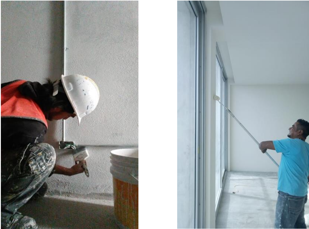
Figura 17. Aplicación de Pintura Vinílica. Edificio Artema. Puebla, México (2018). Elaboración propia
