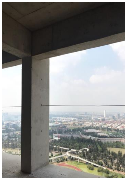
Figura 59. Vano para cancel fachada norte nivel 20, Edificio Artema. Puebla, México (2018). Elaboración propia.
