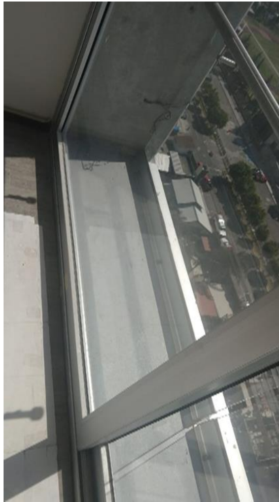
Figura 35. Piso epóxico en Balcón. Edificio Artema. Puebla, México (2018). Elaboración propia.
