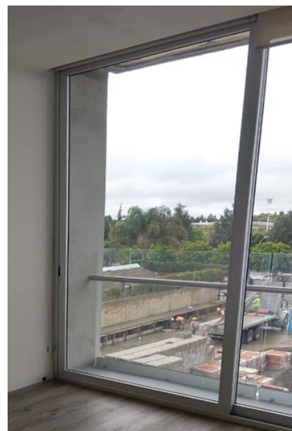
Figura 60. Cancel Depto.104 con solera a los lados, Edificio Artema. Puebla, México (2018). Elaboración propia.
