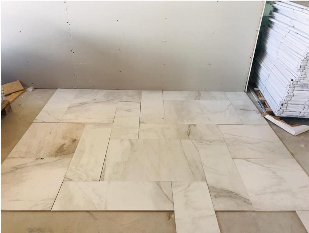
Figura 29. Despiece de Porcelanato en Salón de Fiestas. Edificio Artema. Puebla, México (2018). Elaboración propia.
