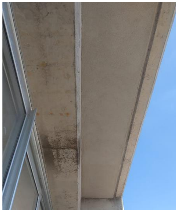
Figura 16. Instalación de Panel de Cemento en Balcón. Edificio Artema. Puebla, México (2018). Elaboración propia.
