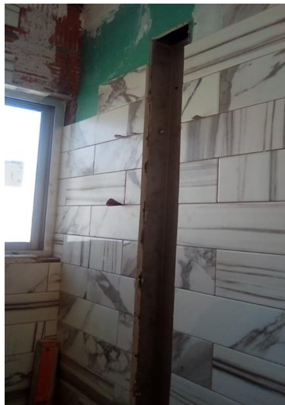
Figura 65. Baño vestidor con charola de baño. Edificio Artema. Puebla, México (2018). Elaboración propia.
