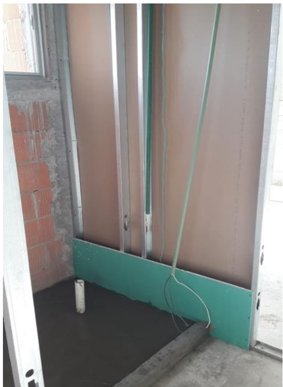
Figura 64. Instalación de postes como soporte. Edificio Artema. Puebla, México (2018). Elaboración propia
