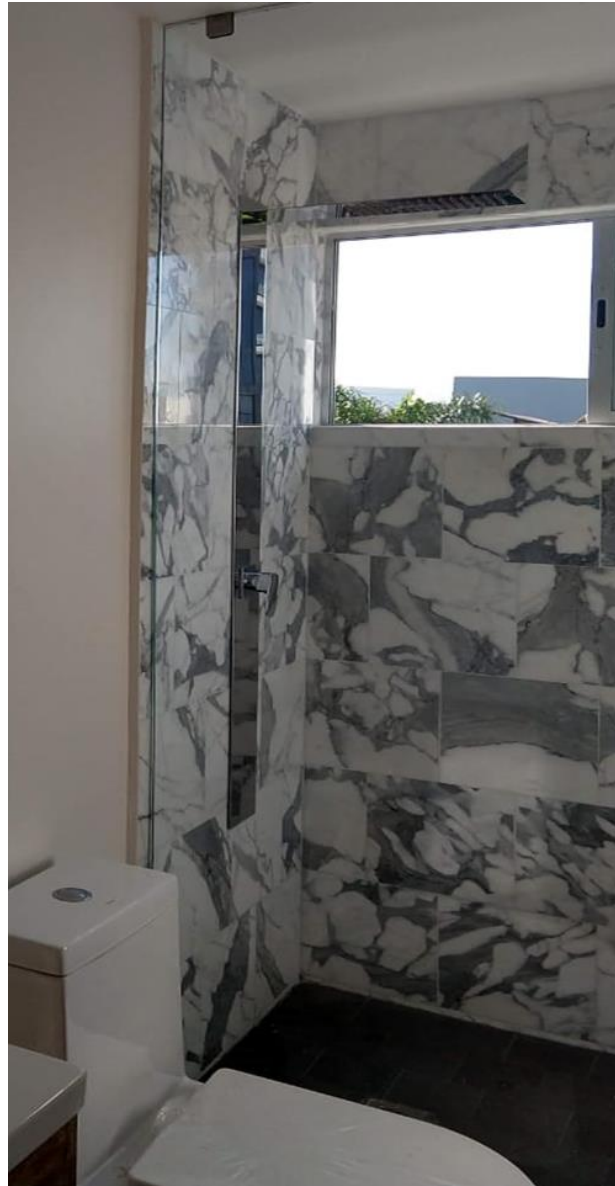
Figura 30. Instalación de Mármol en Muros de Regadera. Edificio Artema. Puebla, México (2018). Elaboración propia.
