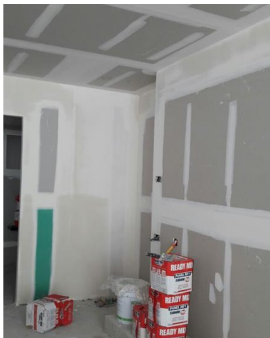
Figura 7. Instalación de Hoja Panel de Yeso Estándar. Edificio Artema. Puebla, México (2018). Elaboración propia.
