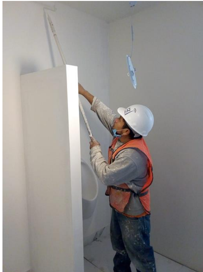
Figura 18. Aplicación de Pintura Esmalte en Baños. Edificio Artema. Puebla, México (2018). Elaboración propia.
