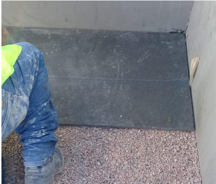
Figura 33. Colocación de piso en Terraza sobre Gravilla. Edificio Artema. Puebla, México (2018). Elaboración propia.
