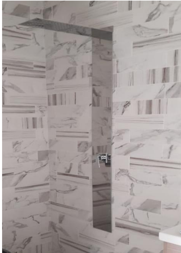
Figura 66. Regadera terminada con tapa instalada. Edificio Artema. Puebla, México (2018). Elaboración propia.
