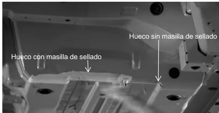
Figura 21. Aplicación de masillas de sellado.
