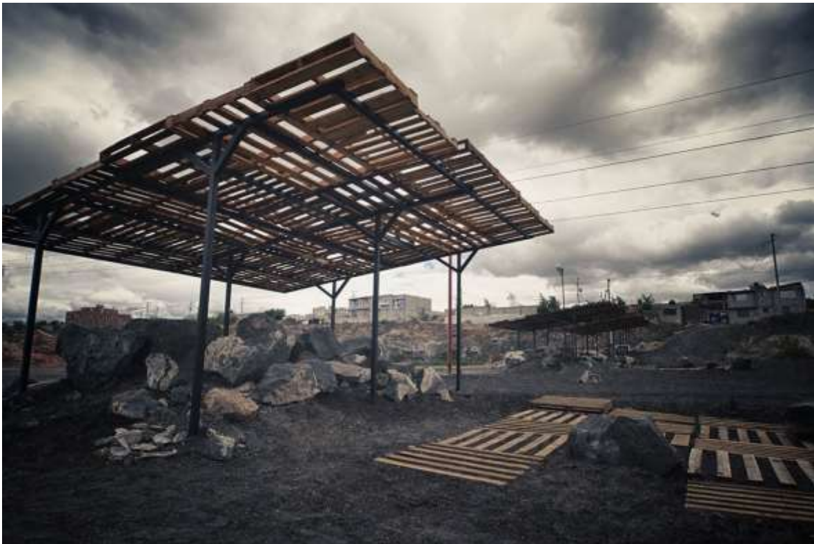
(Fotografías del estado actual de la cancha .(Arquiteturapanamericana.com, 2018)
