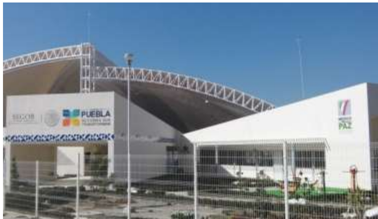
Area de gimnasio al aire libre
