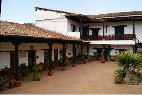
Fotografía 2. Vivienda de adobe
