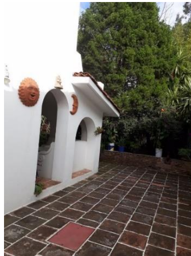
Fotografía 1. Vivienda de adobe
