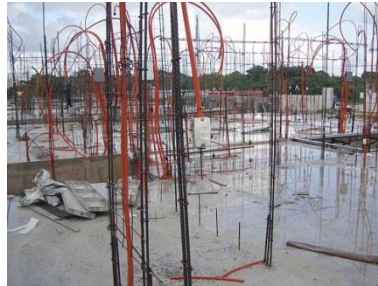
Imagen 8. Habilitado de acero para muros, ducterías en muros.
