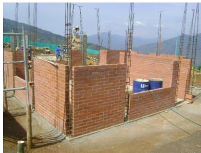
Imagen 2. Sistema constructivo tradicional para vivienda de interés social.
