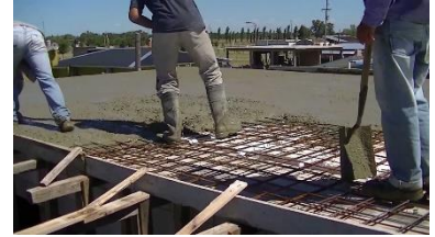
Imagen 6. Sistema de cubierta Losa Maciza.
