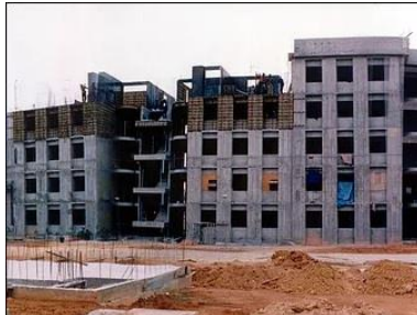
Imagen 14. Losa de cimentación al frente. Al fondo multifamiliar en proceso de habilitado de cimbra.
