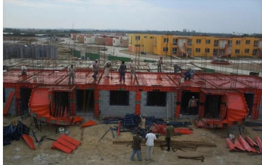
Imagen 17. Habilitado de cimbra TRADIMECC para multifamiliar.
