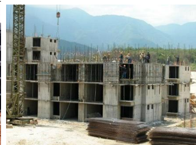
Imagen 15. Multifamiliar en proceso de habilitado de acero en muros.
