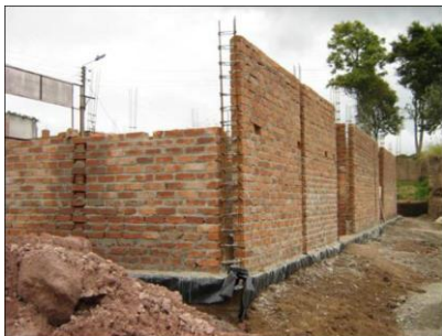
Imagen 1. Sistema tradicional Dalas-Muros-Castillos.
