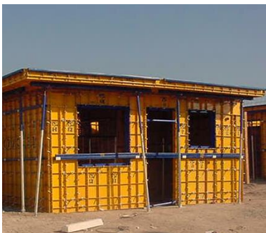
Imagen 10. Molde habilitado en planta baja.
