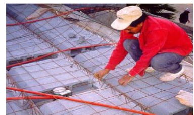
Imagen 3. Sistema de cubierta Vigueta-Bovedilla.
