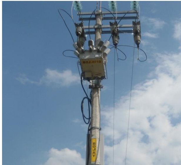
Figura 2.13 Restaurador en líneas de media tensión.
