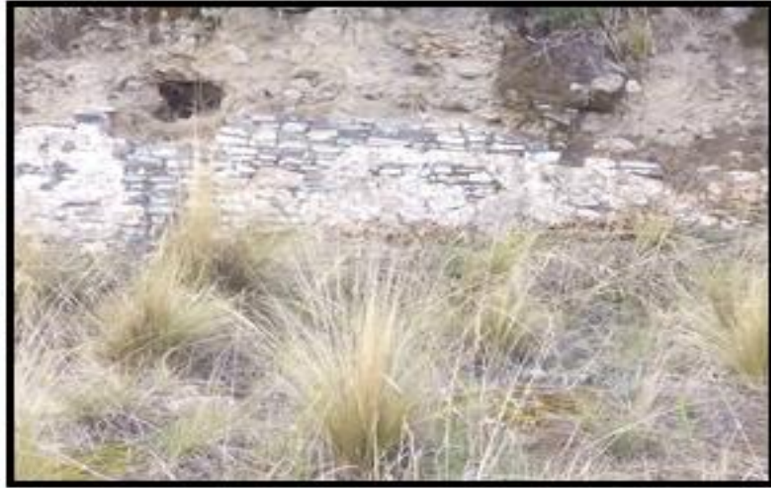
Fig. 12. Sección de la estructura de estudio, que sobresale en la parte Sur de la zona prospectada.
