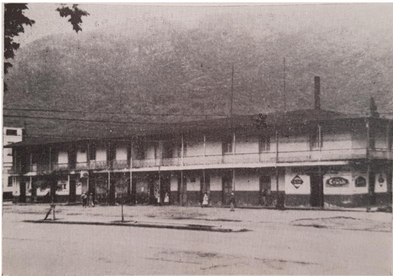
Fachada actual de la casa donde estuviera la tienda de raya; incendiada el 7 de enero de 1907.—Río Blanco, Ver.
