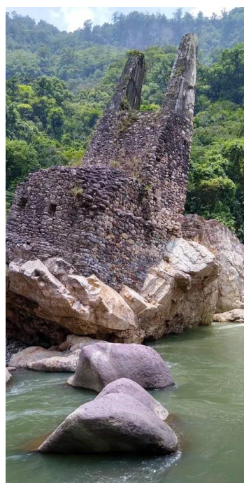
Foto 10: Restos del puente antiguo que funciono en el año 1929.
