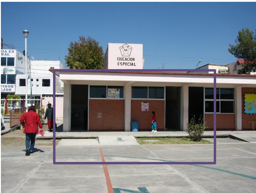
Imagen 64. Módulo de sanitarios en el edificio de estimulación temprana, pre-escolar y primaria. Centro de Atención Múltiple Tepeaca. Ubicado en calle Francisco I. Madero (Foto septiembre 2010).
