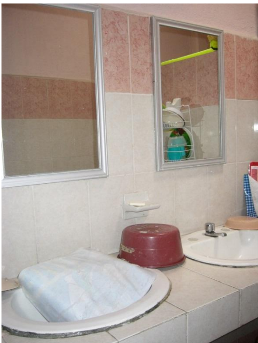
Imagen 70. Módulo de Sanitarios, área de dirección y aulas del nivel primaria. Centro de Atención Múltiple Tepeaca. Ubicado en calle Francisco I. Madero. (Foto septiembre 2010).
