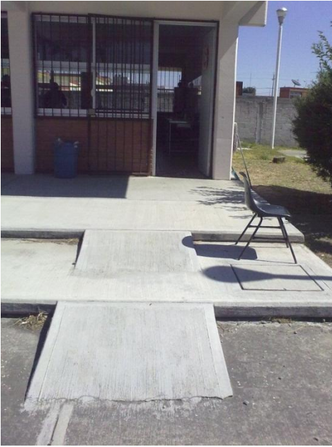
Imagen 60. Taller de cocina, rampa. Centro de Atención Múltiple Tepeaca. Ubicado en calle Francisco I. Madero entre (Foto septiembre 2010).
