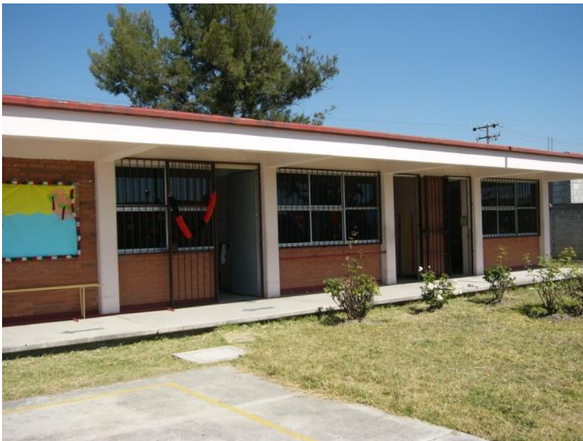
Imagen 57. Pasillo de sanitarios y aula primaria, preescolar y estimulación temprana, donde se cuenta con barandal. Centro de Atención Múltiple Tepeaca. Ubicado en calle Francisco I. Madero (Foto septiembre 2010).
