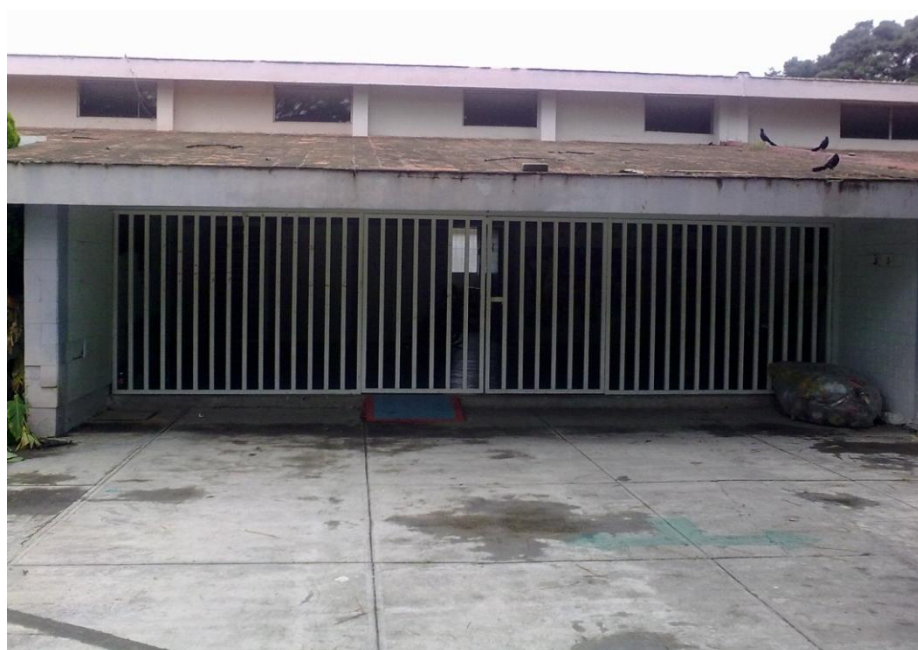
Imagen 30. Acceso al área designada para educación nivel primaria (acceso a salones), CAM Col. San Miguel Cd. Puebla (foto tomada mayo 2010).
