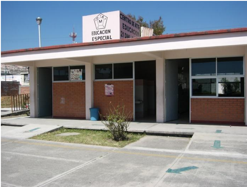
Imagen 56. Pasillo de sanitarios y aula primaria, preescolar y estimulación temprana. Centro de Atención Múltiple Tepeaca. Ubicado en calle Francisco I. Madero (Foto septiembre 2010)
