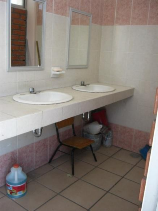
Imagen 66. Sanitarios, área de lavabos a una altura de 60 cm. Centro de Atención Múltiple Tepeaca. Ubicado en calle Francisco I. Madero. (Foto septiembre 2010)
