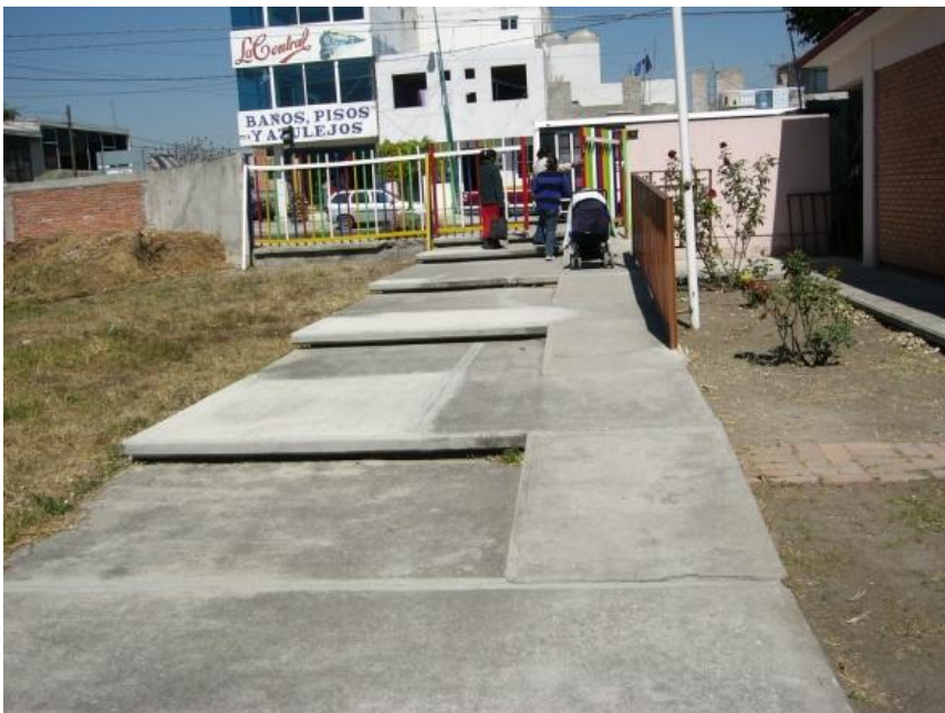
Imagen 55. Acceso interior Centro de Atención Múltiple Tepeaca, ubicación de la rampa. Ubicado en calle Francisco I. Madero (Foto septiembre 2010)
