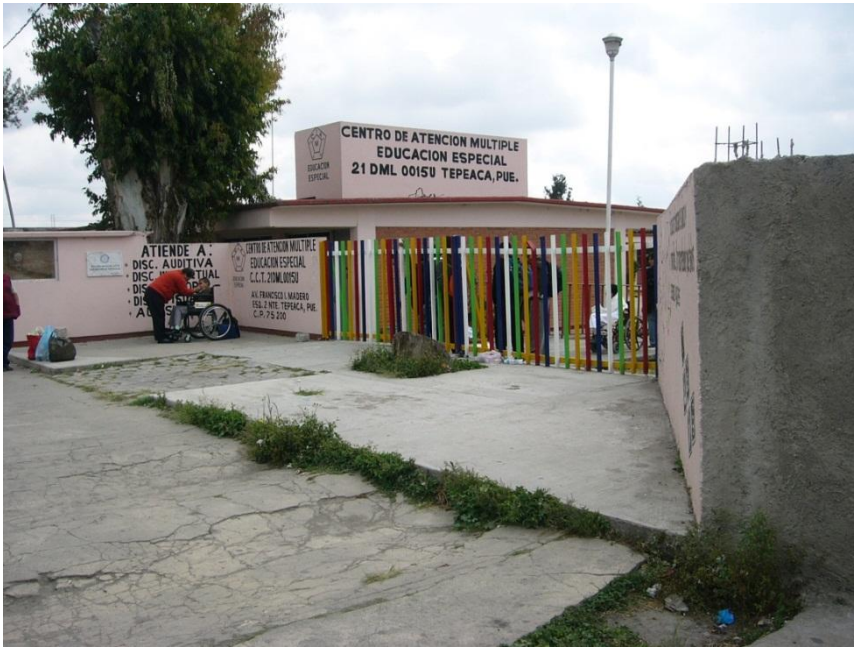
Imagen 54. Acceso exterior Centro de Atención Múltiple Tepeaca. Ubicado en calle Francisco I. Madero (Foto septiembre 2010).
