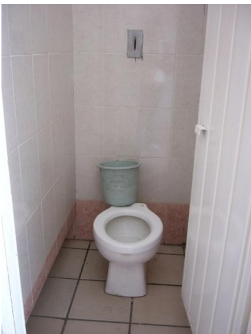
Imagen 65. Sanitarios en un área de 60 cm de ancho por 70 cm de largo. Centro de Atención Múltiple Tepeaca. Ubicado en calle Francisco I. Madero (Foto septiembre 2010)
