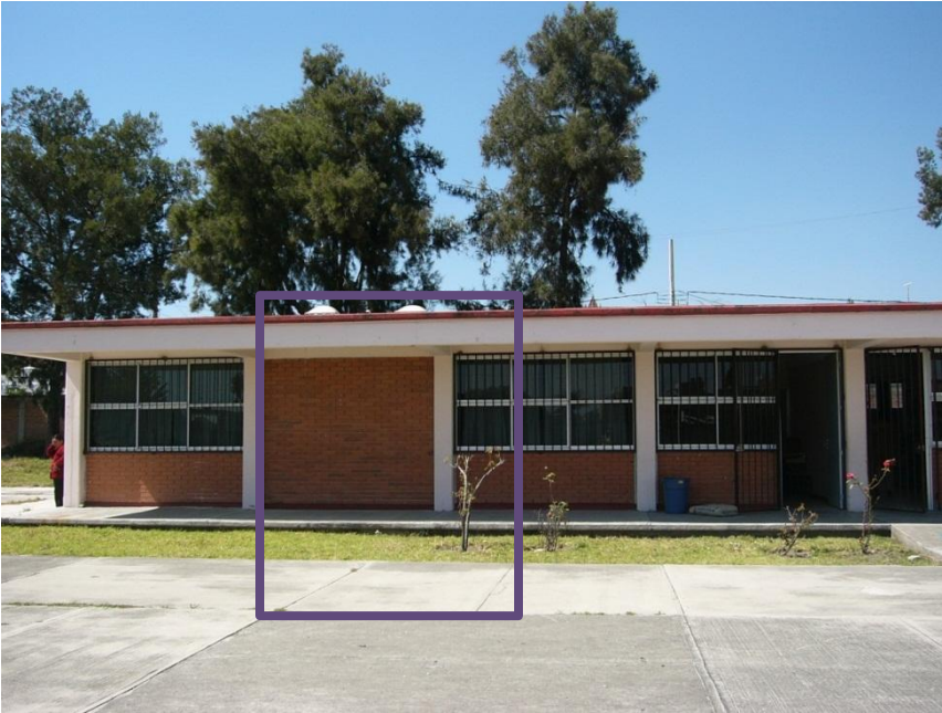
Imagen 68. Módulo de Sanitarios, área de dirección y aulas del nivel primaria. Centro de Atención Múltiple Tepeaca. Ubicado en calle Francisco I. Madero. (Foto septiembre 2010).
