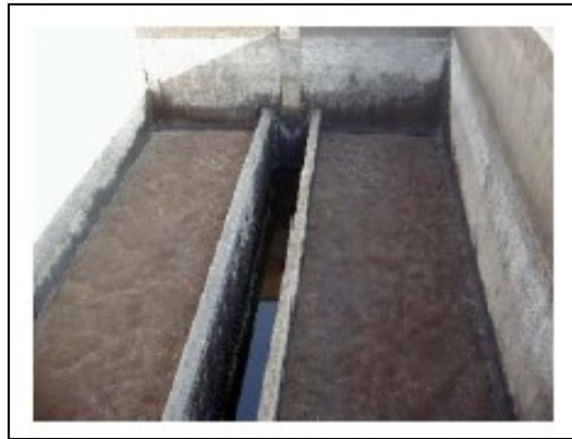
Fig. 3.16.- Lecho de arena del filtro y canaleta.
