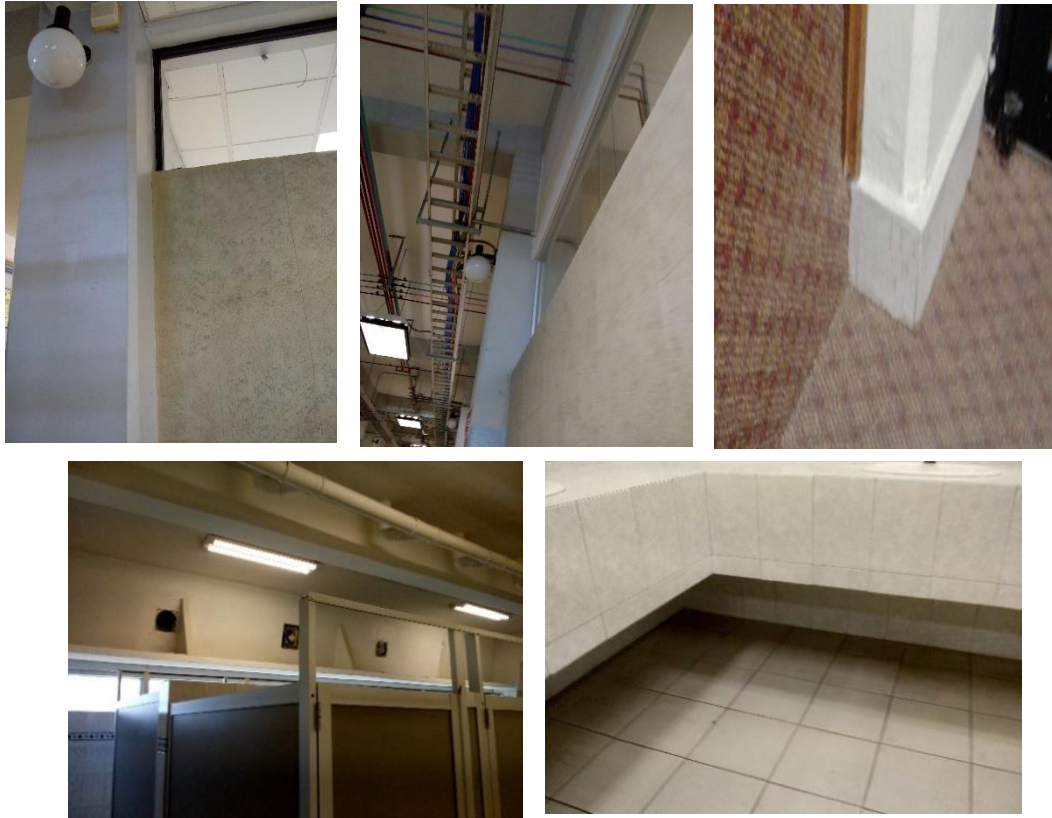
Figura 9. Inspección en áreas del edificio FCQ9 de la facultad de Ciencias Químicas- BUAP
