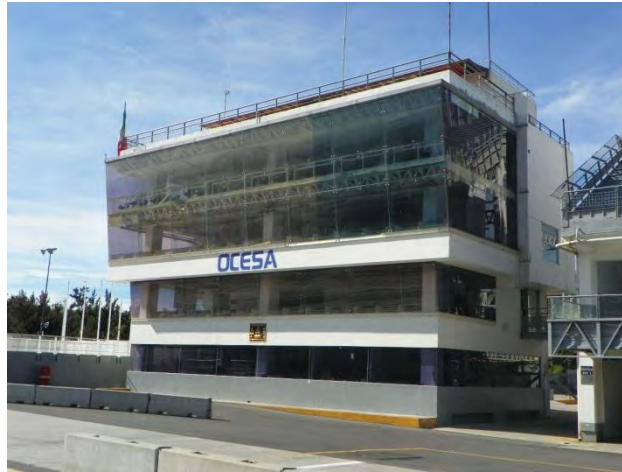
45Torre de control autódromo Hermanos Rodríguez
