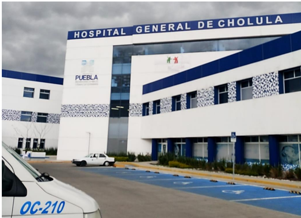
Figura 1. Fachada del Hospital General de Cholula.
