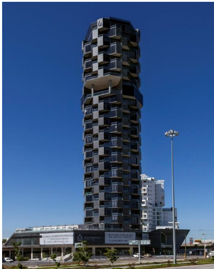
Ilustración 25 Adamant I Fachada
