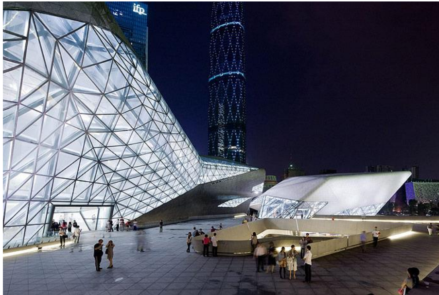
Ilustración 22 Guangzhou Opera House
