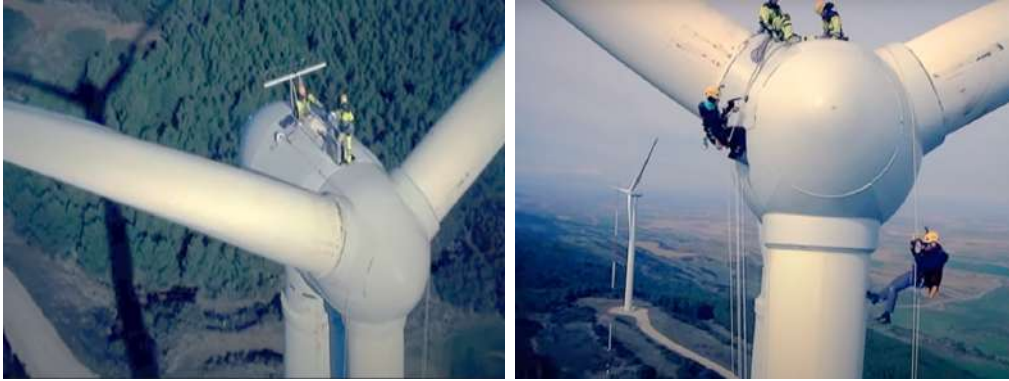
Figura 1: Mantenimiento a aerogeneradores de Artajona, España.
