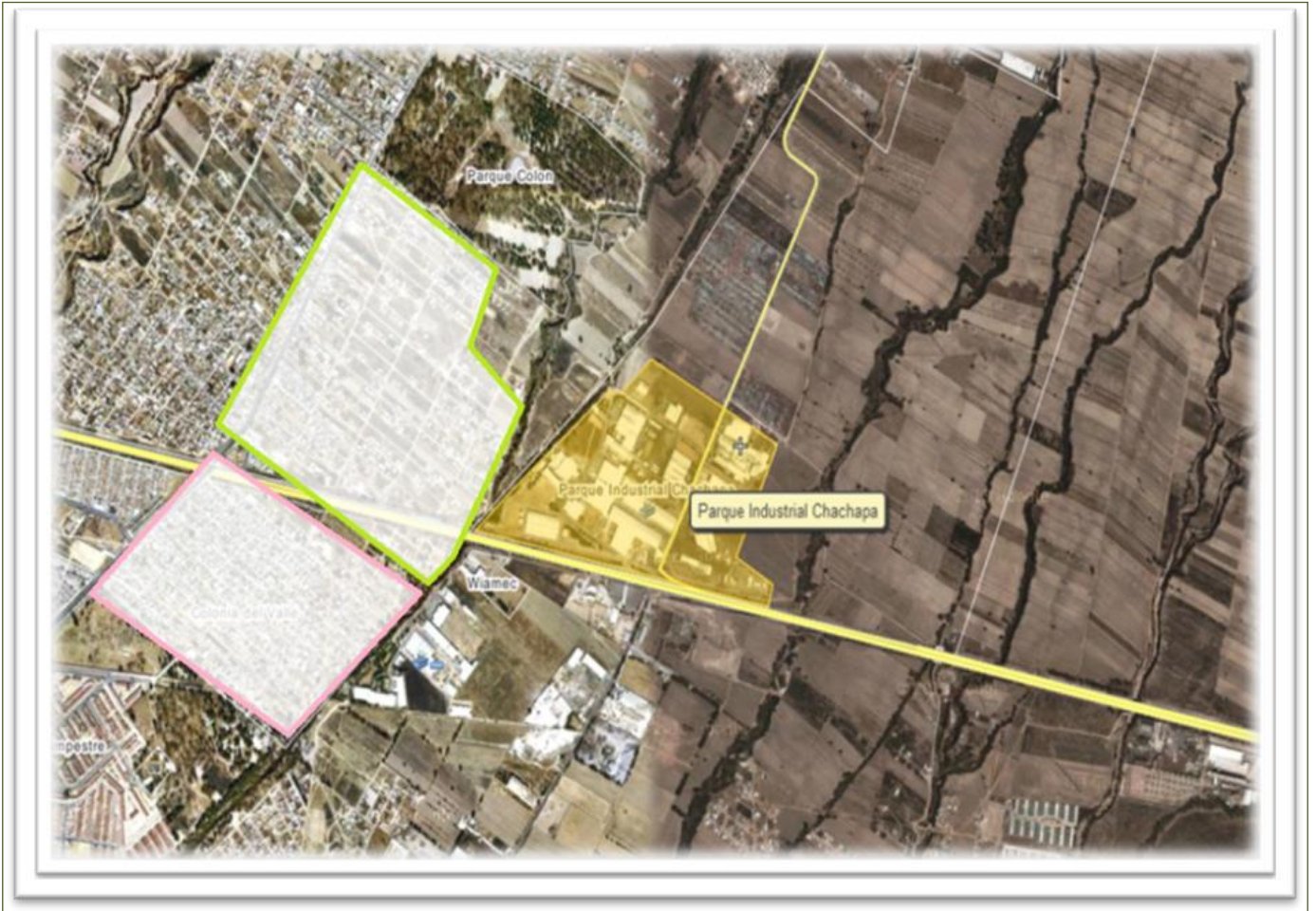
Figura 1. Parque Industrial San Felipe Chachapa. Imagen obtenida de google maps.
