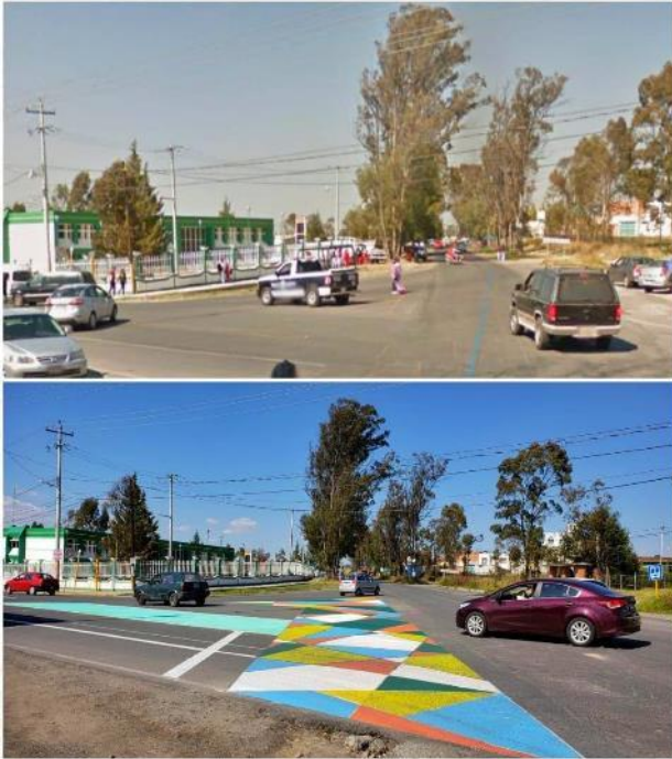
Figura 29. Intervención 2019 (Entronque Apizaco Huamantla)
