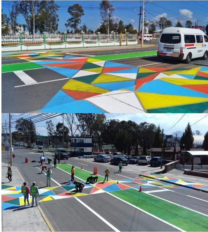
Figura 28. Intervención de urbanismo táctico, 2018 (Entronque Apizaco Huamantla)
