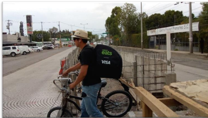
Figura 29 Ciclista atravesando junto a las obras
