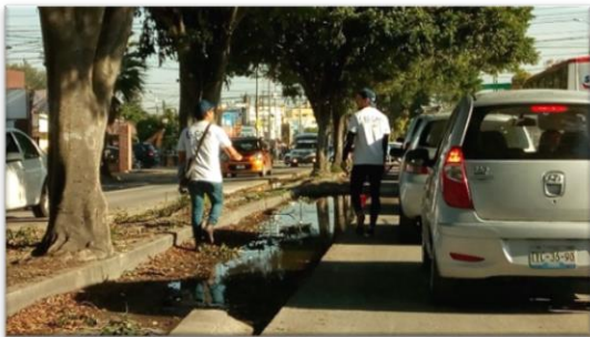
Figura 24 Peatones caminado en el camellón sin asfalto
