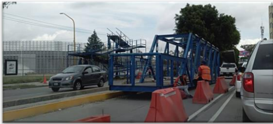
Figura 32 Retiro del puente peatonal de Arquitectura
