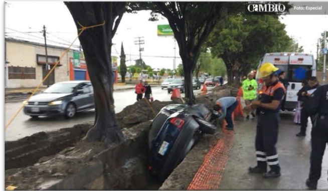
Figura 30 Volcadura de un vehículo en una zanja de las obras en Boulevard Valsequillo y las Torres.
