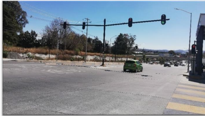
Figura 66 Ausencia de cruce peatonal en la Terminal Valsequillo de la línea 3 del RUTA
