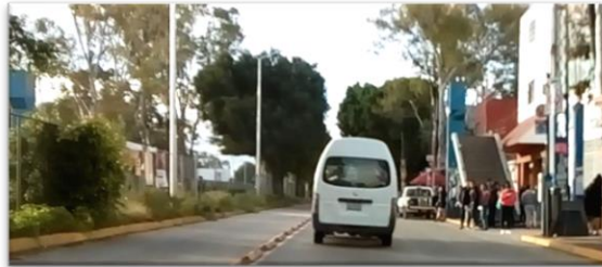
Figura 33 Retiro del puente de Contaduría
