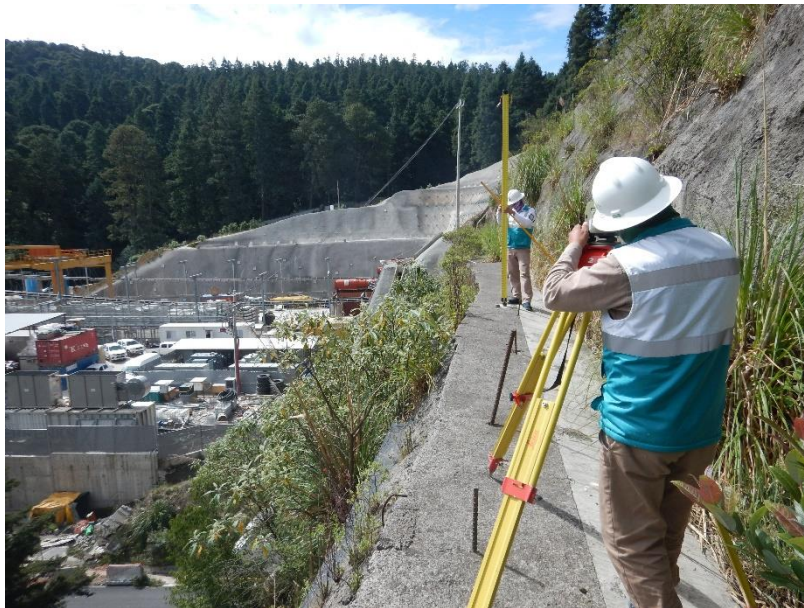
Imagen 41. Control Altimétrico en Bermas de Portal Oriente
