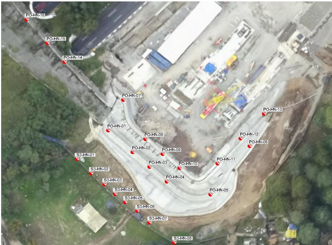
Imagen 40. Ortofoto con localización de instrumentos en sección S3 y Portal Oriente.
