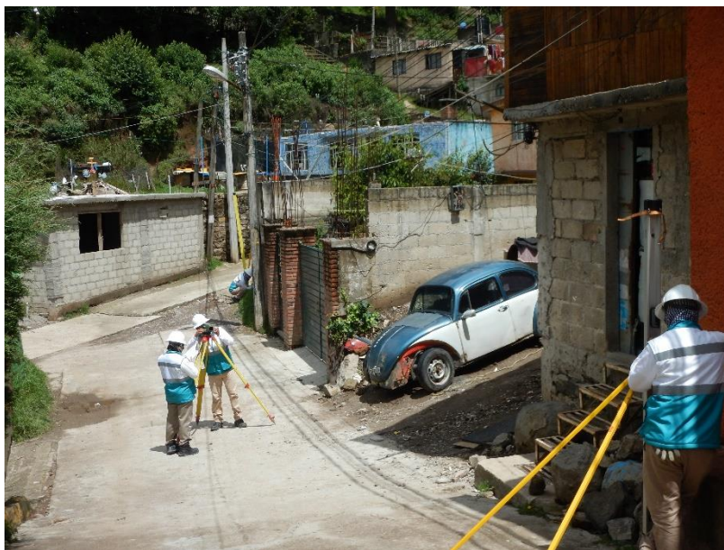
Imagen 27. Nivelación de pijas en S2.
