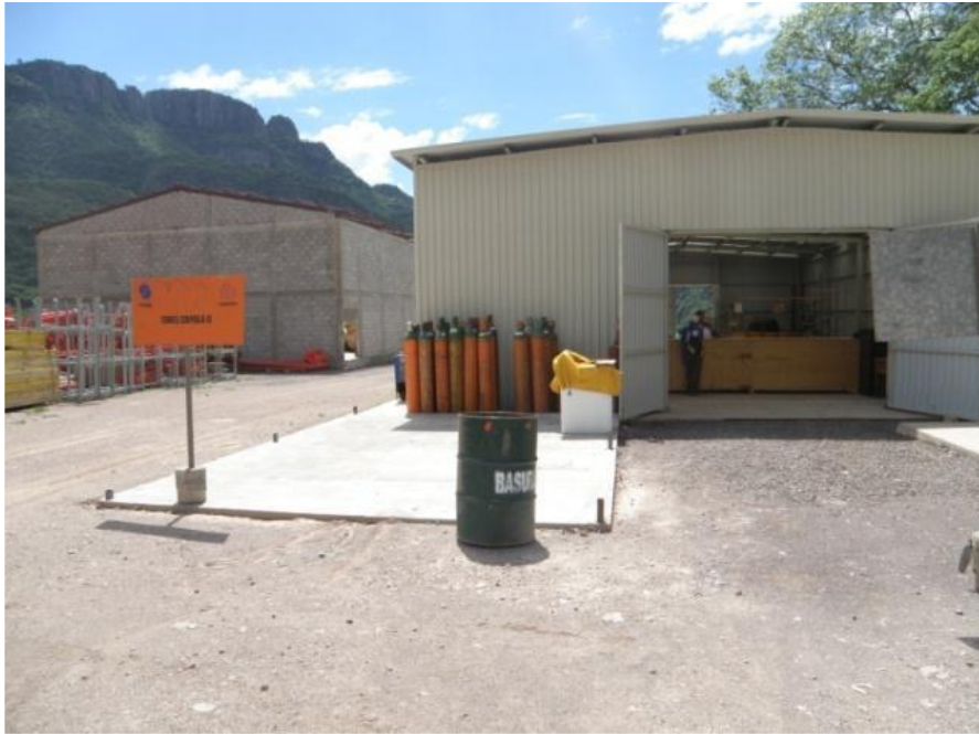
Imagen 38. Estructura provisional de obra.
