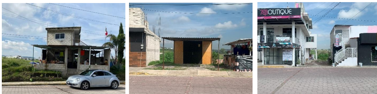
Imagen 4. Diferentes sistemas estructurales y constructivos en el andador. Fotografía: Ortega, 2023.
