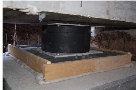
Figura 7. Aislador elastomérico con núcleo de plomo. Fuente: Sísmica.cl.
