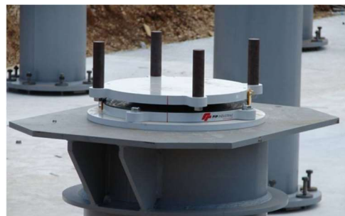
Figura 9. Aislador péndulo de fricción. Fuente: Sísmica.cl.
