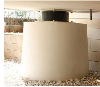
Figura 5. Aislador elastomérico. Fuente: Sísmica.cl.
