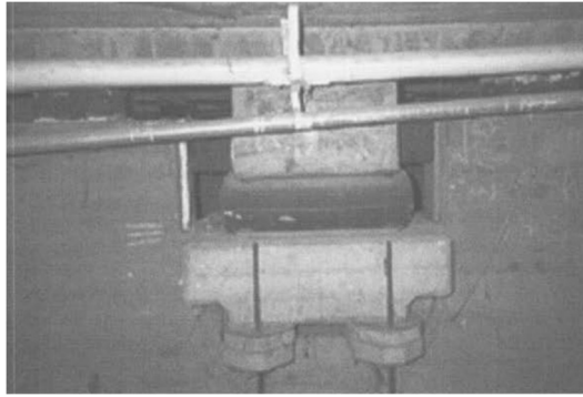
Figura 1. Caucho utilizado en la escuela en Skopje (Naeim & Kelly 1999).
