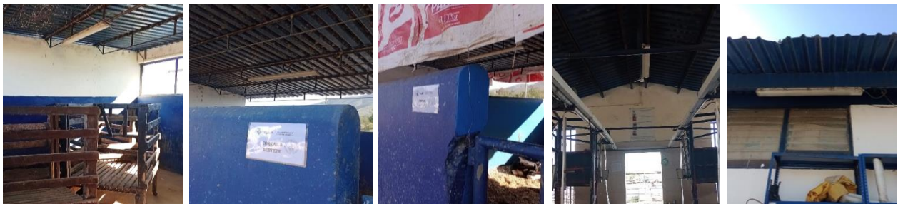
Figura 14 Espacios y corrales con iluminación
