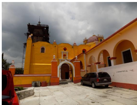
Foto 20 Entrada Lateral y Oficinas
