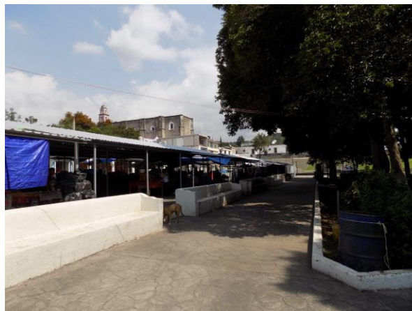
Pasillo entre Mercado Municipal y Plaza. Foto33
