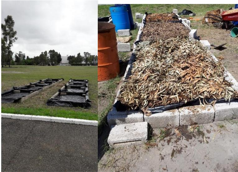
**Figura 11.** Construcción de camas de lombricompostaje y vertido de Residuos Sólidos Orgánicos dentro de éstas (Fuente propia, 2019).
