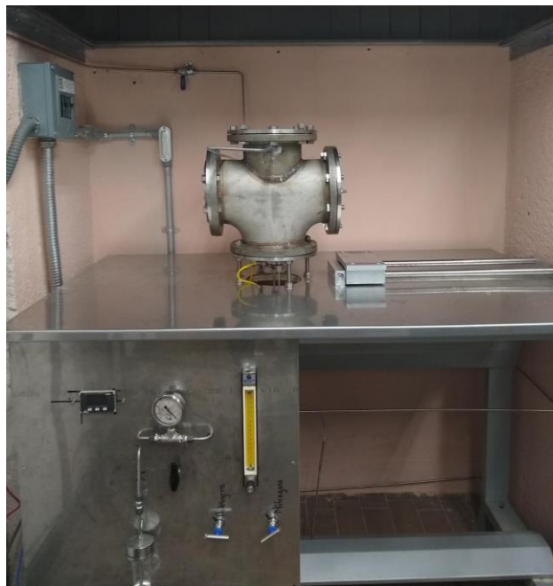
Figura 3.1. instalación del reactor HFCVD.
