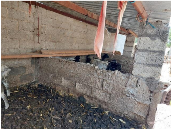
Figura 3: Instalaciones se realizan con recursos que posee el productor, instalación de concreto
