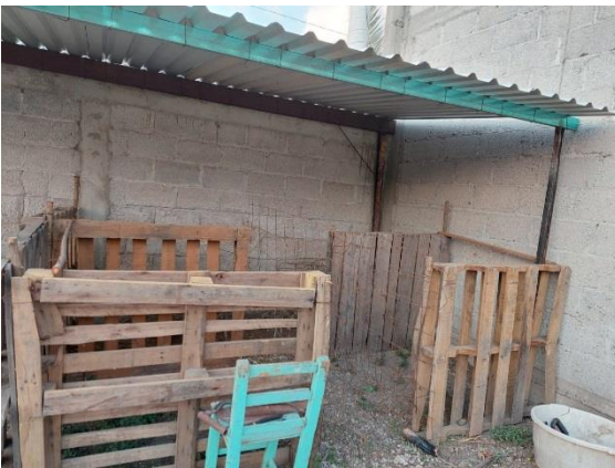
Figura 5: Instalaciones se realizan con recursos que posee el productor, instalación de madera o tarimas
