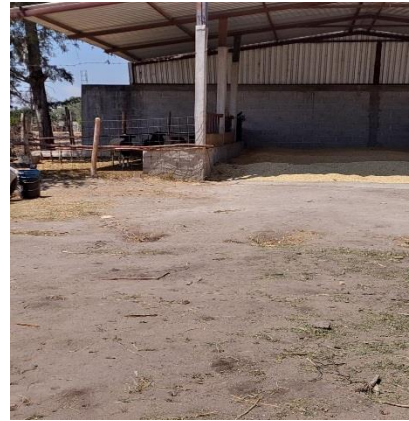
Figura 8: Instalaciones se realizan con recursos que posee el productor, instalación de malla
