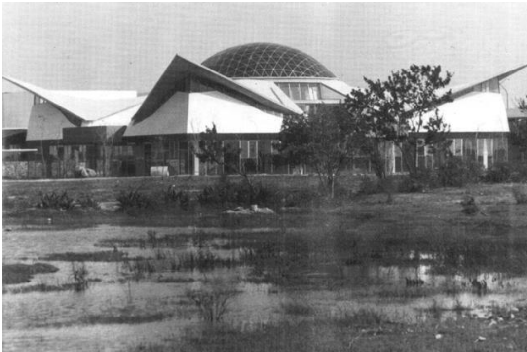
Figura 1 Edificio La Monja
