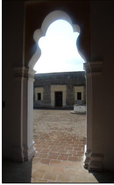
Arco de la casa para ingresar al patio
