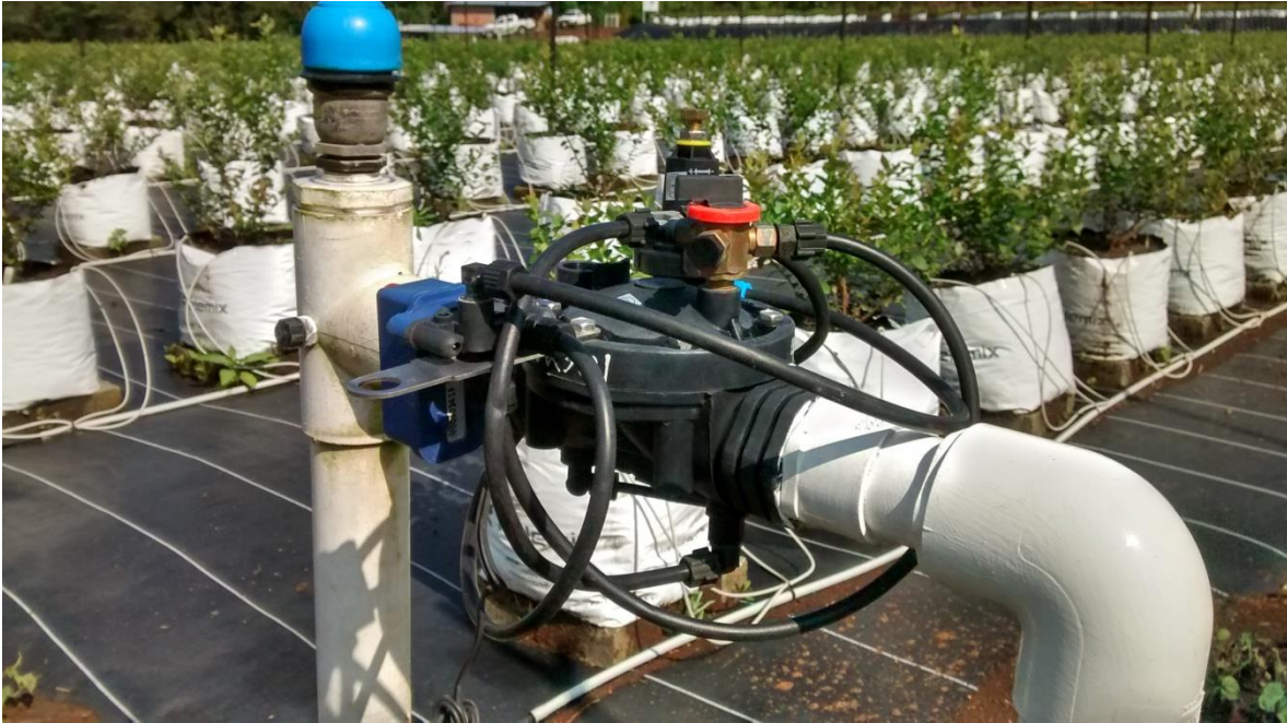
Figura 28.- Construcción de válvula de control tipo 2
