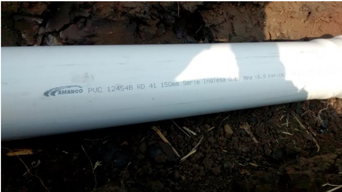
Figura 26.- Tubería amanco en zanja
