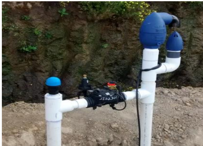
Figura 27.- Construcción de válvula de control tipo 1
