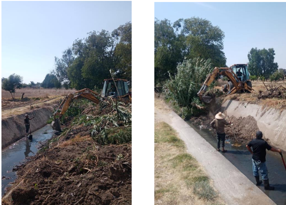
Figura 9. Vecinos de la comunidad realizando el desazolve de La Laguna de Acuitlapilco.
