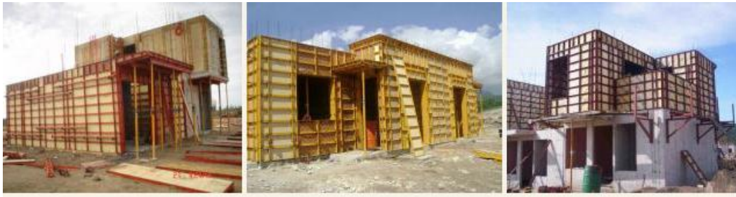
Gráfico 22. Sistema monolítico de cimbra para vivienda marca Construidea® [21].
