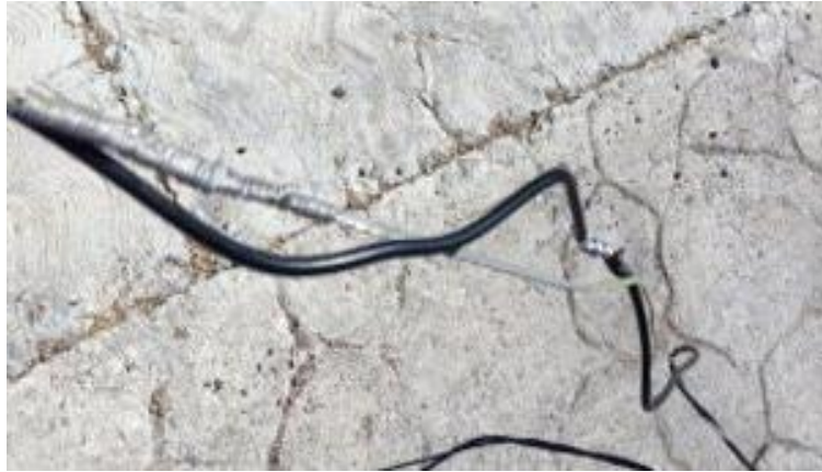
Figura 4. Falsos contactos
