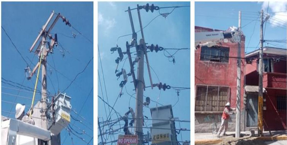
Figura 18. Cambio de cortacircuitos fusibles, apartarrayos y cambio de poste
