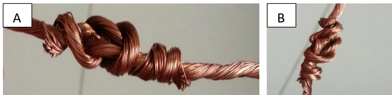
Figura 2.18. Ejemplos de empalme: vuelta de escota. A) Empalme vuelta de escota en horizontal. B) Empalme vuelta de escota en vertical.
